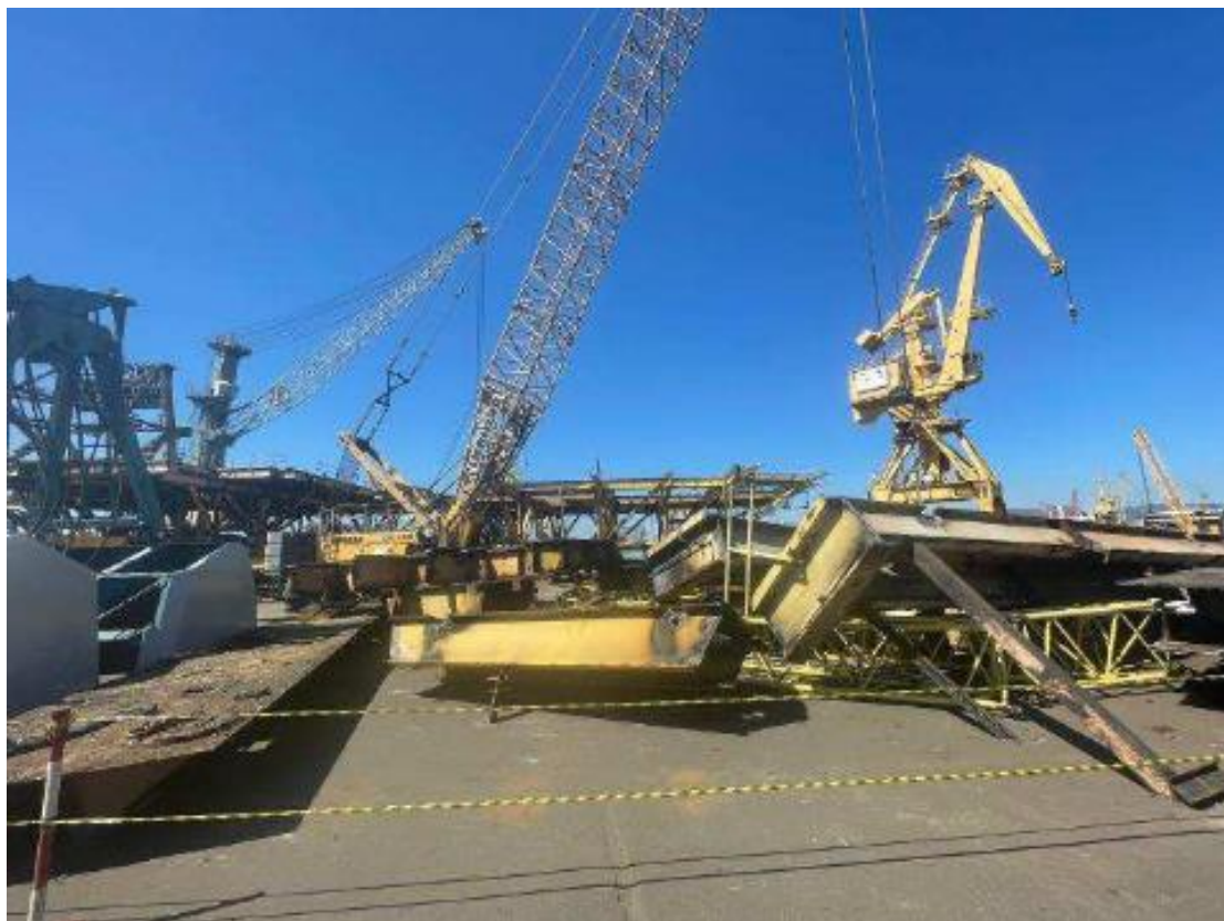
Corte das estruturas no Porto do Rio
