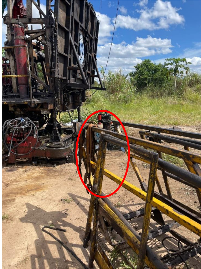
Figura 12. Foto do cinto trava-quedas do torrlista, tirada após o incidente, sugerindo que o trabalhador não estava usando o cinto no momento da queda.
