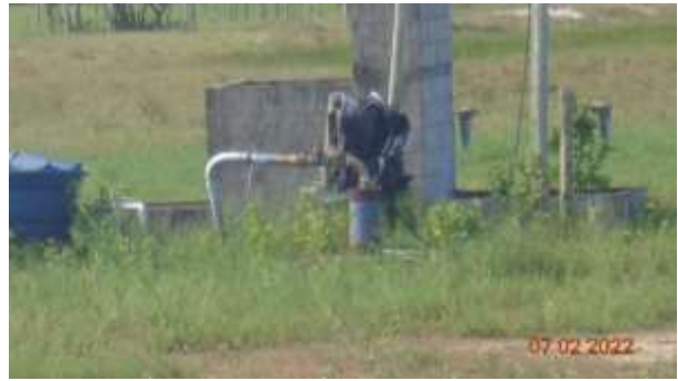
Foto 7: Detalhe de poço artesiano instalado no local, hoje utilizado pelo proprietário da área.
