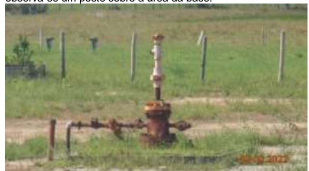
Foto 5: Equipamentos instalados na área da base, visada nordeste.
