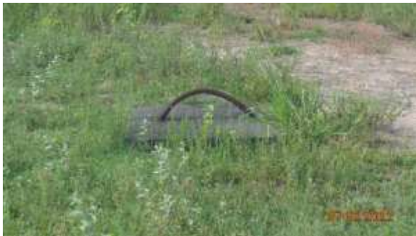
Foto 8: Blocos de ancoragem existentes no local.
