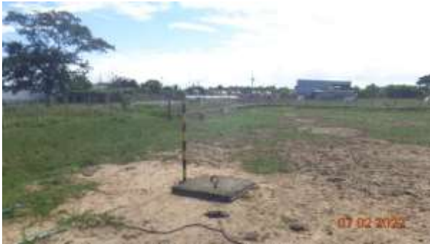
Foto 16: Bloco de ancoragem ainda instalado no local (visada à oeste).
