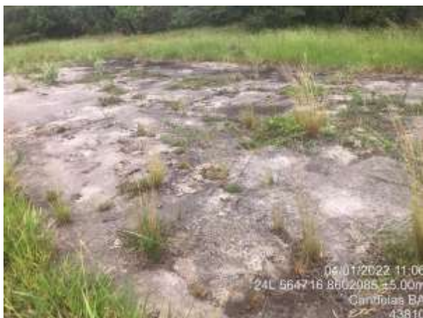
Foto 01. A base encontra-se com piso de concreto e vegetação de gramíneas.
