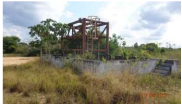
Figura 5: Equipamentos de superf cie 1-RIB-1-ES
