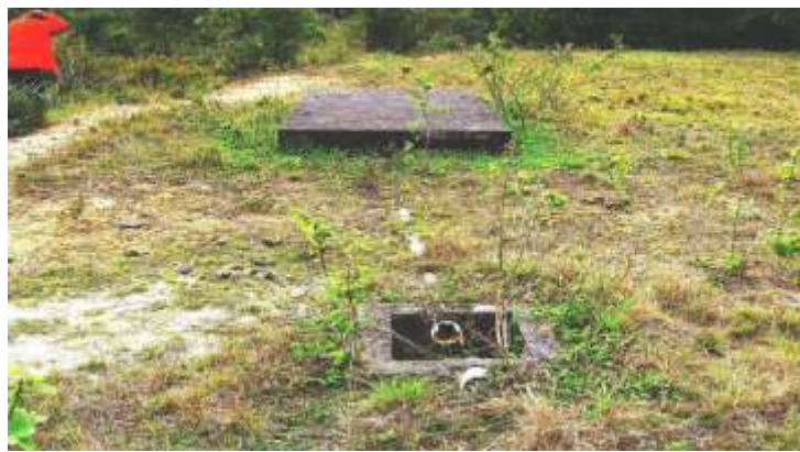
Figura 22: Fossa e caixa de contenção
