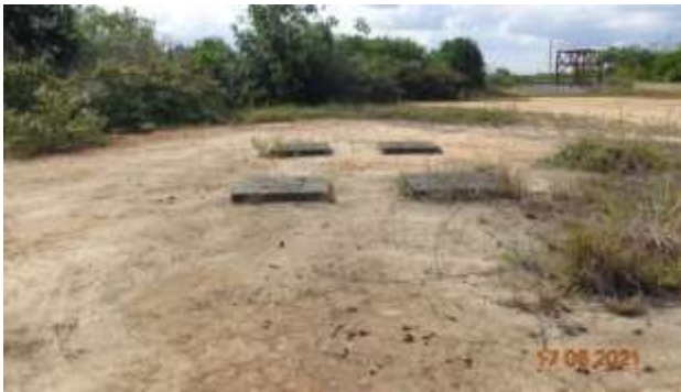
Figura 8: Equipamentos de superfície 1-RIB-1-ES
