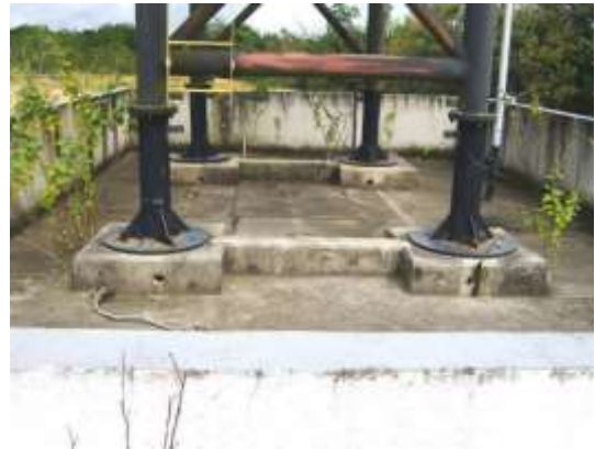
Figuras 21: Bacia de contenção e skid de suportes para tanque
