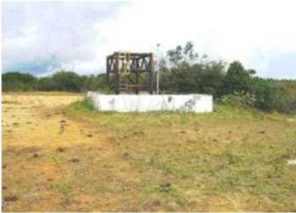
Figuras 21: Bacia de contenção e skid de suportes para tanque
