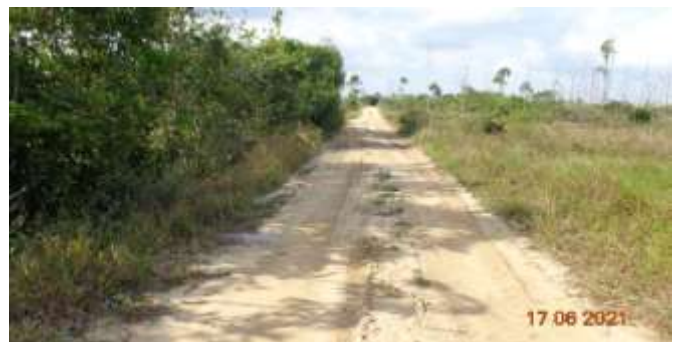
Figura 17: Vista parcial do acesso a área da base do poço 3-RIB-3-ES. Bordas do acesso vegetadas.
