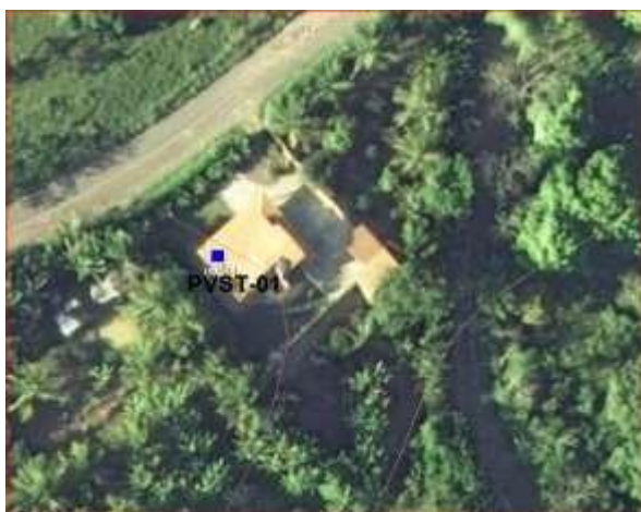
Fig. 30: Casa sobre a base do Poço PVST-01.
