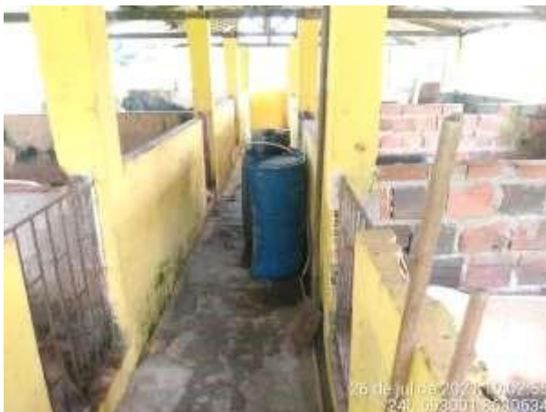
Foto 1: Base do poço possui concreto; não foi concreto, não foi
