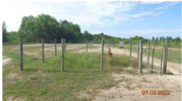
Foto 6: Equipamentos de elevação instalados na área da base, visada nordeste.
