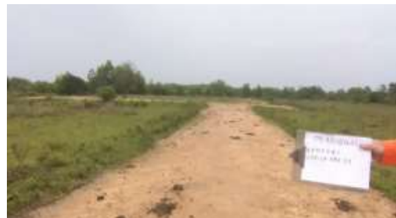
Foto 22: Vista do antigo acesso e (ao fundo) a área da base.
