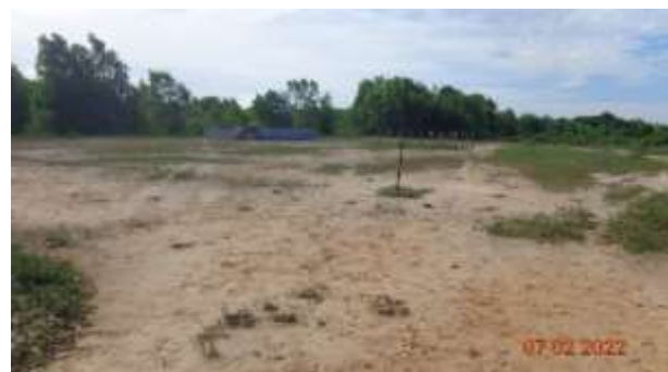
Foto 4: Vista da porção final do acesso ao poço, bem como a área da base e sua bacia de contenção.
