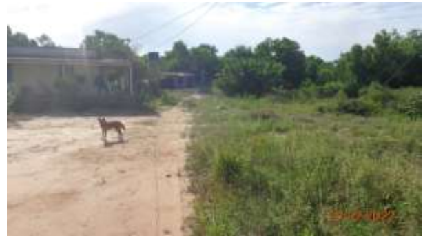
Foto 13: Área da base nivelada como o terreno vizinho, livre de processos erosivos e com suas extremidades revegetadas (visada à oeste).
