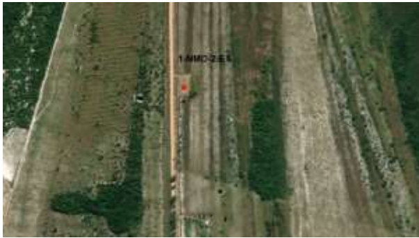
Foto 17: O destaque na imagem aérea indica o local onde foi implantada a área da base do poço 1-NMO-2-ES.
