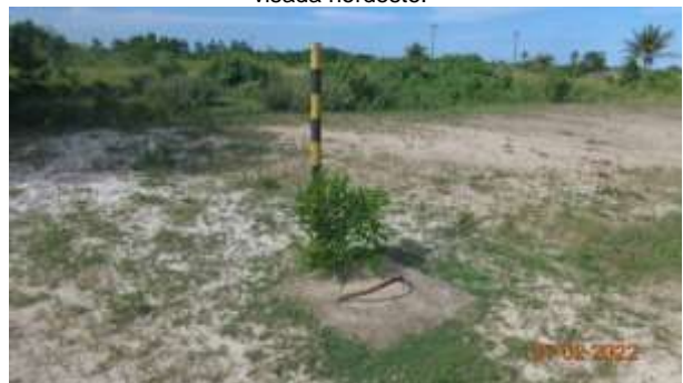
Foto 8: Bloco de ancoragem existente no local.
