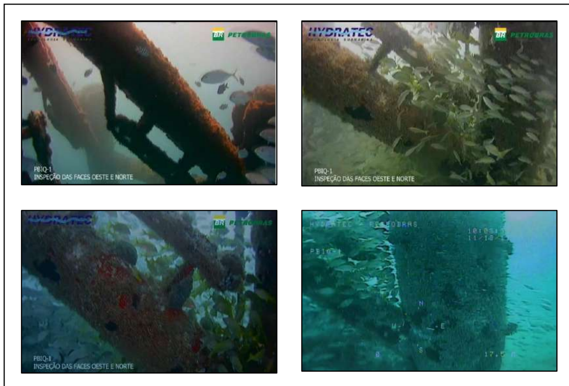
Figura 7.1-XV: Imageamento das faces oeste e norte da estrutura da jaqueta da plataforma fixa PBIQ-01
