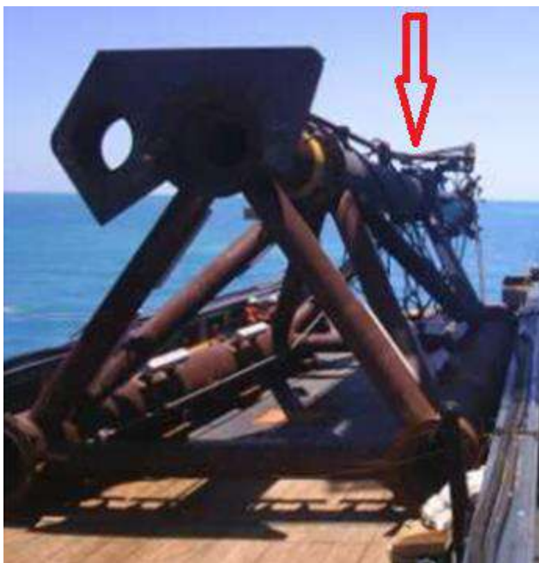
Figura 3.3-VI – Riser da PBIQ-01 já conectado a jaqueta durante a sua instalação
