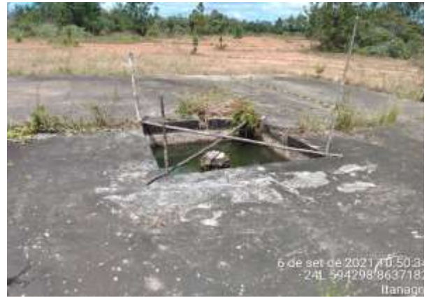
Fig.: 07: Esse poço possui piso de concreto e ante-poço
