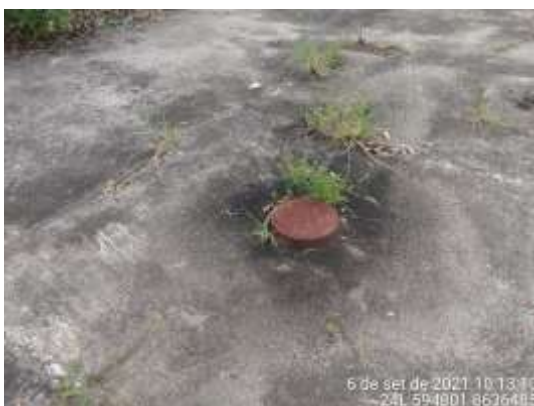
Fig.: 01: Base de concreto e ante-poço tamponado
