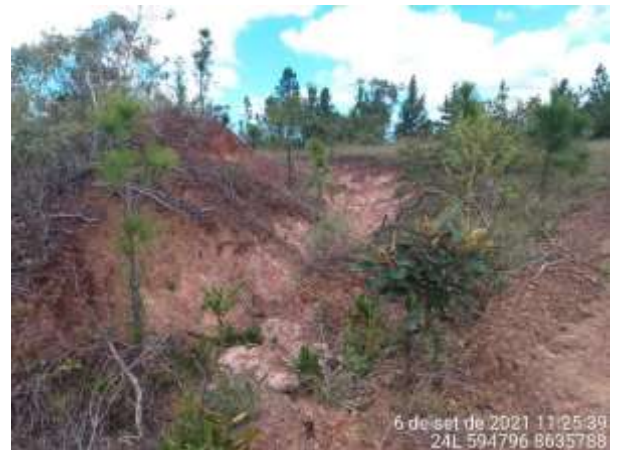
Fig. 04: Processos erosivo no acesso do poço LV-02
