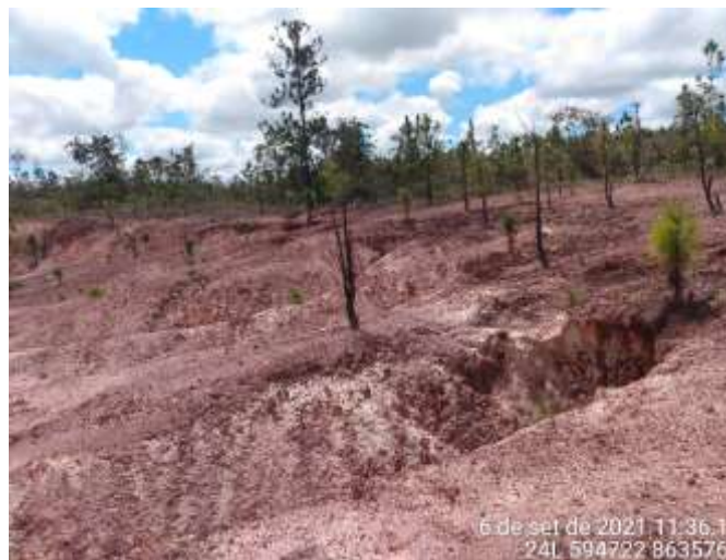
Fig. 05: Solo exposto, processos erosivos e carreamento de sedimentos para o afluente do Rio Imbassai
