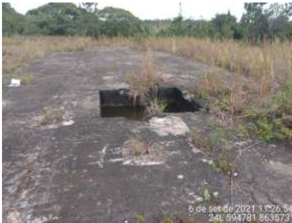
Fig. 03: Poço com piso de concreto e ante-poço
