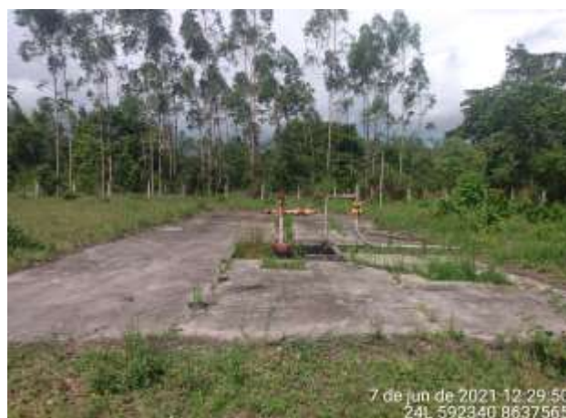
Fig 4: A base do poço possui piso de concreto, equipamento estrutural e ante poço aberto.
