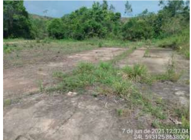
Fig. 6: Este poço possui apenas a base cimentada.
