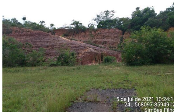
Foto 13: Talude desnudo e apresentando processos erosivos estabilizados, a montante da base do poço.
