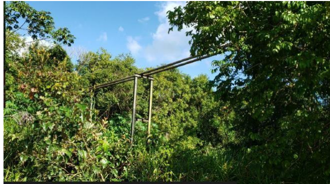
Foto 02: Trechos de linhas desativadas
