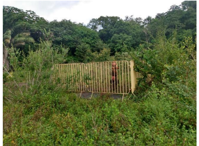
Foto 09: Área do poço com base de concreto, estrutura operacional e grade de proteção.
