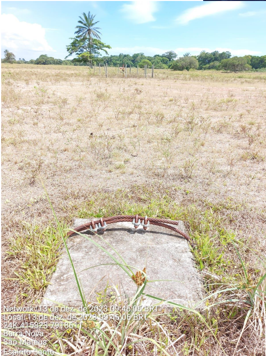
Figura 2: Vista da área do poço LMR-01. Equipamentos de superfície e bloco de ancoragem. (Visada no sentido Norte).
