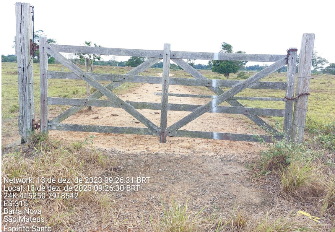
Figura 1: Detalhe atual da via de acesso (sentido Leste), compactada com argila, conforme solicitado pelo proprietário.
