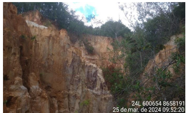
Foto 07 e 08: Talude de corte com processos erosivos relevantes ocasionando formação de voçorocas
