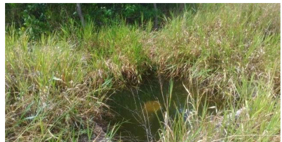
Foto 03: Cabeça do poço tamponado com acúmulo de água
