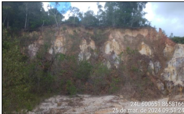
Foto 07 e 08: Talude de corte com processos erosivos relevantes ocasionando formação de voçorocas
