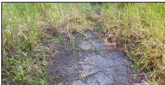
Foto 02: Base de concreto
