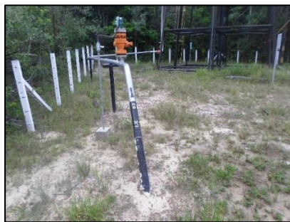
Foto 19: Duto de Coleta do Poço 1-LE-02-BA
