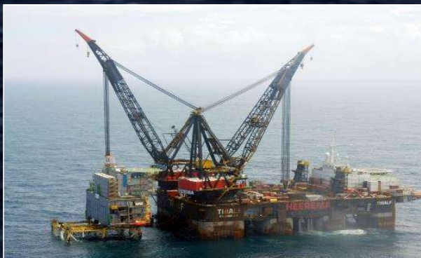
Íçamento Módulos Topside
