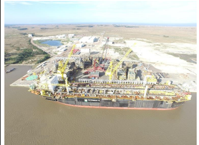
Figura 2 – Visão área do estaleiro em 08/08/2016, mês de entrada do Pedido de Waiver. Obras de implantação do estaleiro 100% concluídas e em plena operação.
