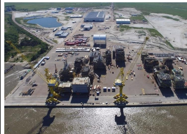
Figura 1 – Área de Fabricação e Montagem final de Módulos e Estruturas no Estaleiro EBR em 18/01/2016
