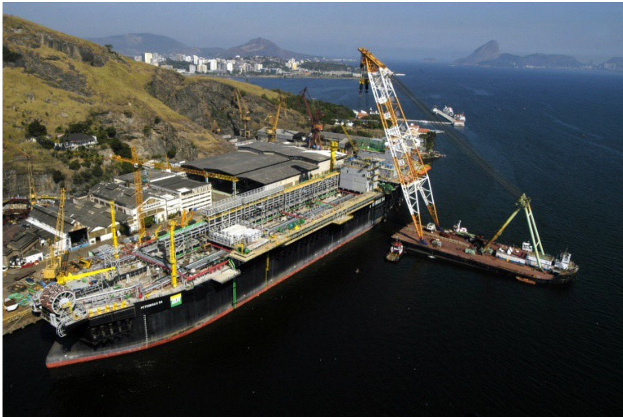
Figura 12 – FPSO P-54 – Instalação de Módulo no cais 1 do Estaleiro Mauá
