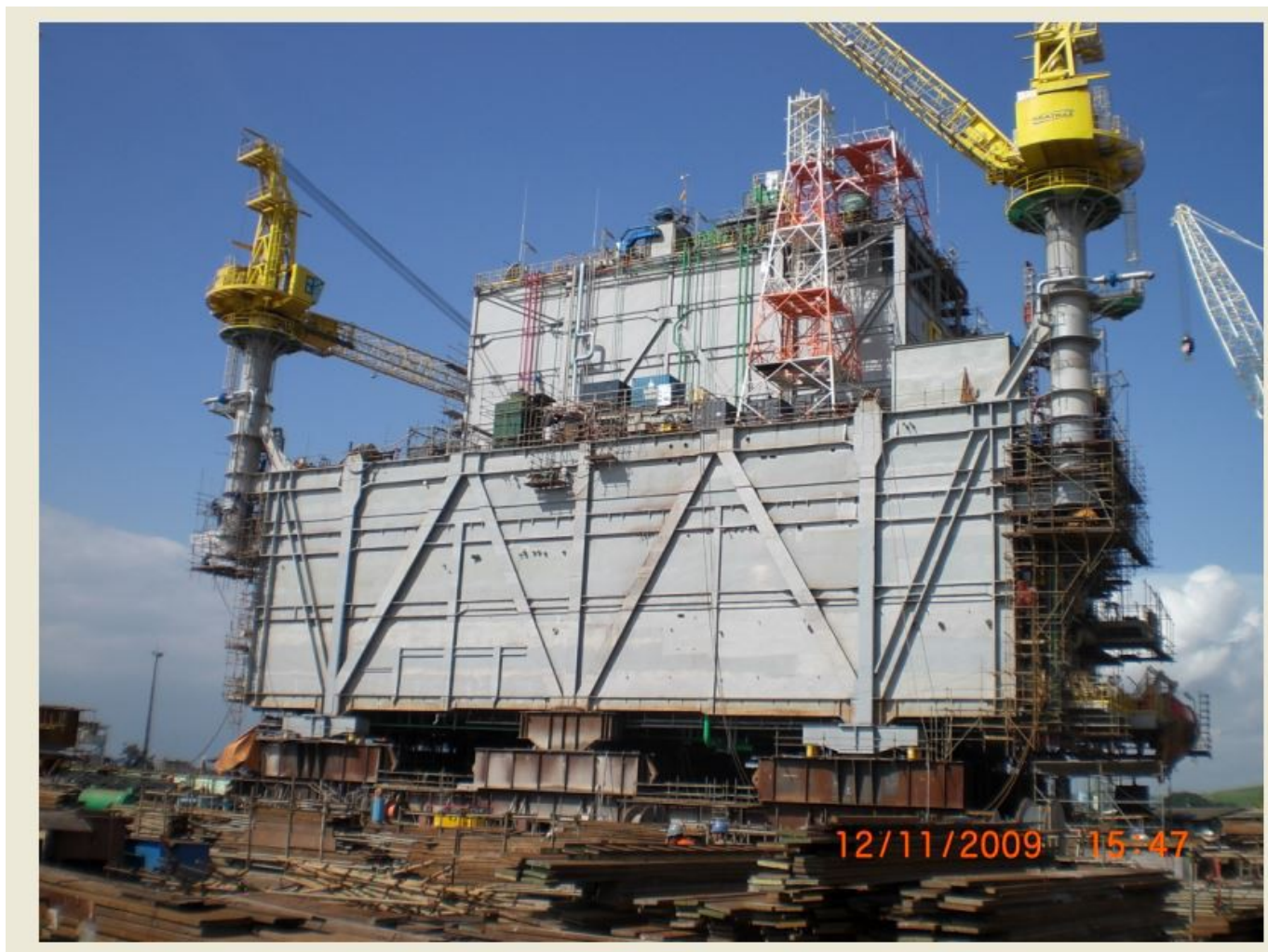
Figura 6 – Instalação do Módulo M03 sobre o M02 da Plataforma PMXL-1 em construção no canteiro na Ilha da Conceição do Estaleiro Mauá
