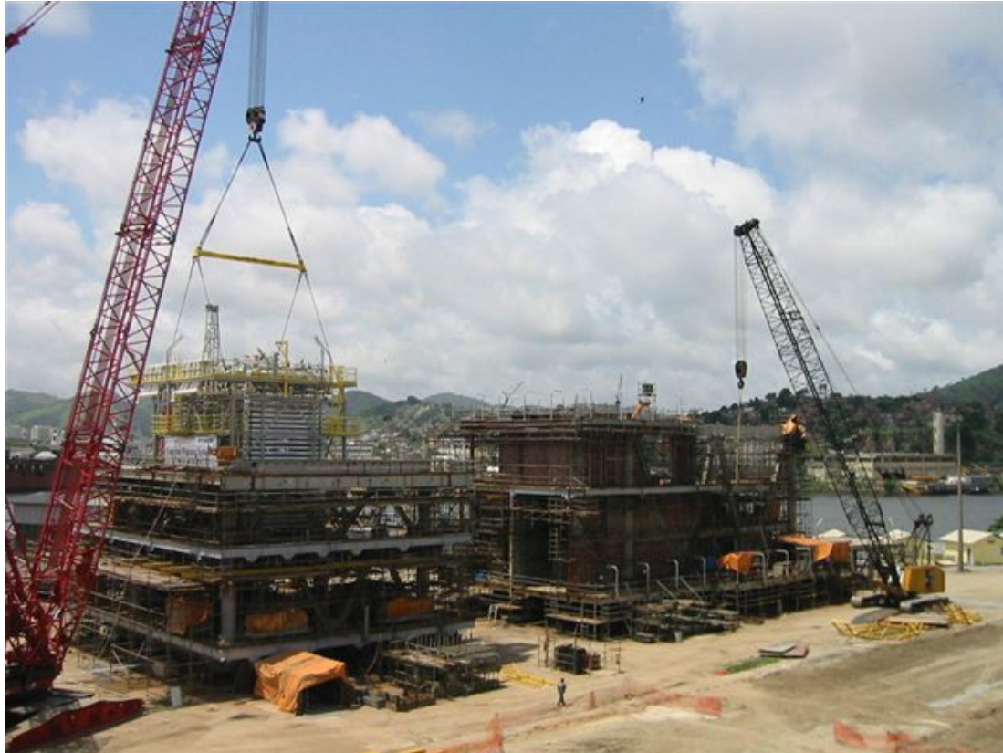
Figura 2 – Módulo de Remoção de Sulfato do FPSO P-50 em construção no canteiro na Ilha da Conceição do Estaleiro Mauá
