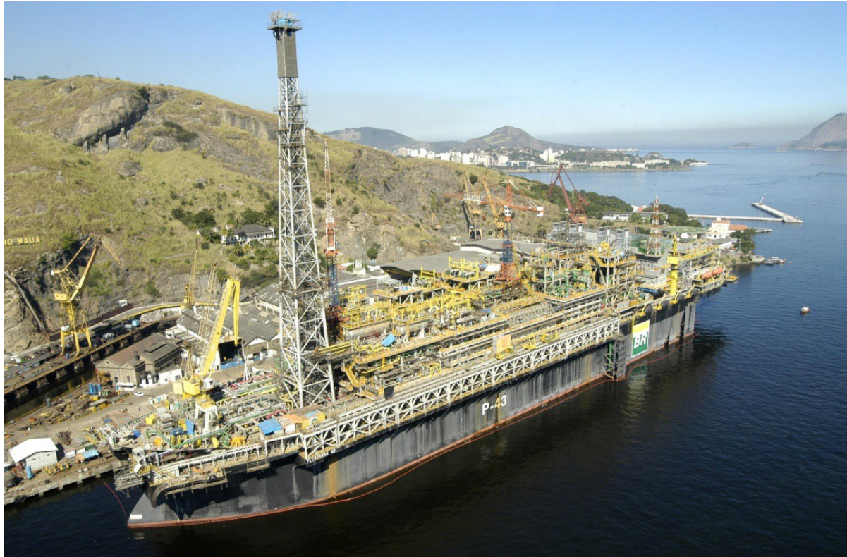
Figura 9 – FPSO P-43 – Atracado no cais 1 do Estaleiro Mauá durante Integração e Comissionamento
