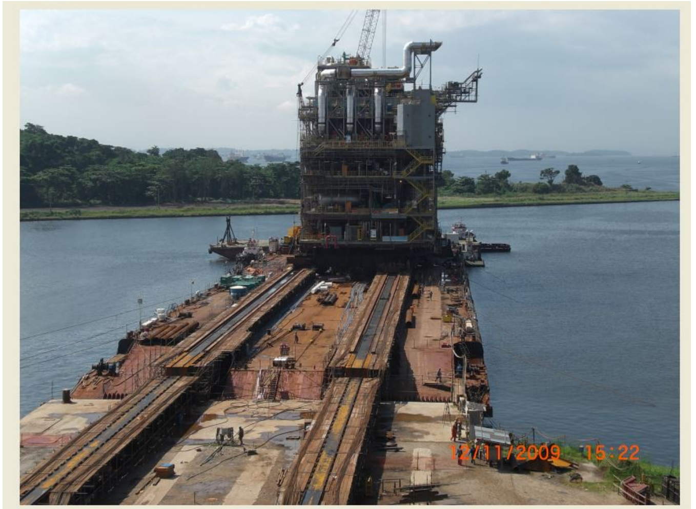
Figura 7 – Módulos M01/M04/M05 sobre balsa após Load-out, da Plataforma PMXL-1 no canteiro na Ilha da Conceição do Estaleiro Mauá
