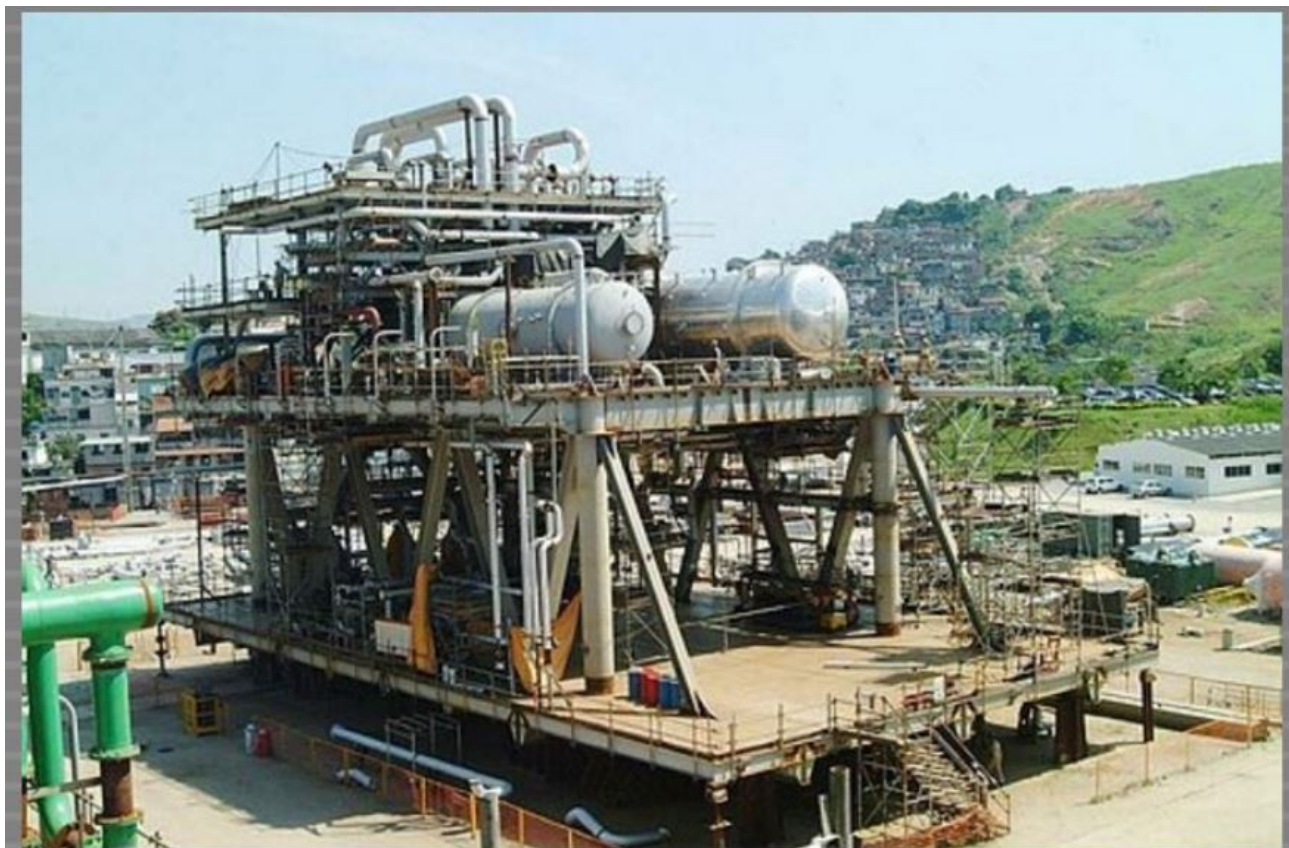
Description: P-54 - Módulo P-03A
