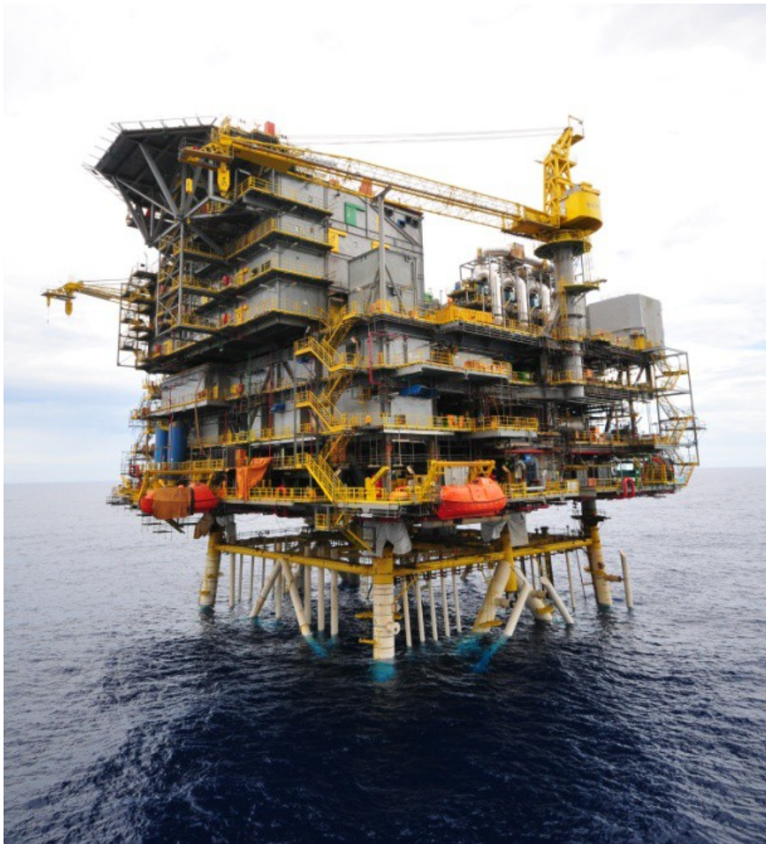
Figura 14 – Plataforma PMXL-1, após instalação offshore, antes dos serviços do Hook-Up offshore e Pré-operação
