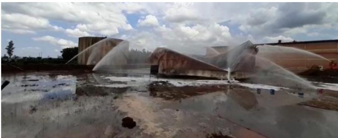
Figura 5 – Resfriamento do TQ-03 após extinção do fogo.
