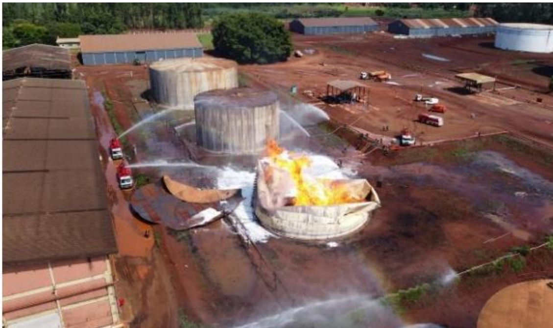
Figura 4 – Vista lateral da projeção de LGE no TQ-03 em chamas e do teto no solo.
