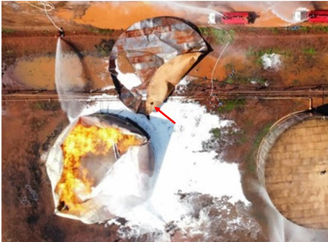
Figura 25 – Vista aérea do TQ-03 em chamas. No detalhe, a indicação da posição da boca de visita.
