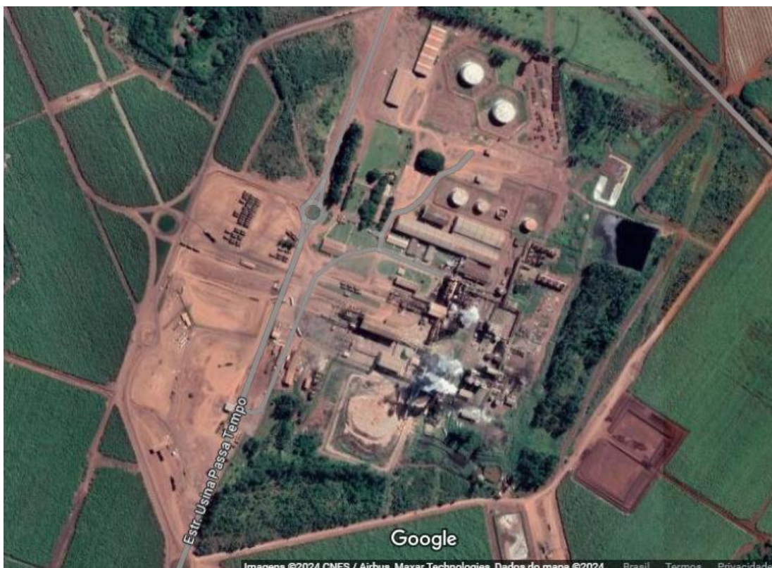
Figura 1 – Vista aérea da instalação.
