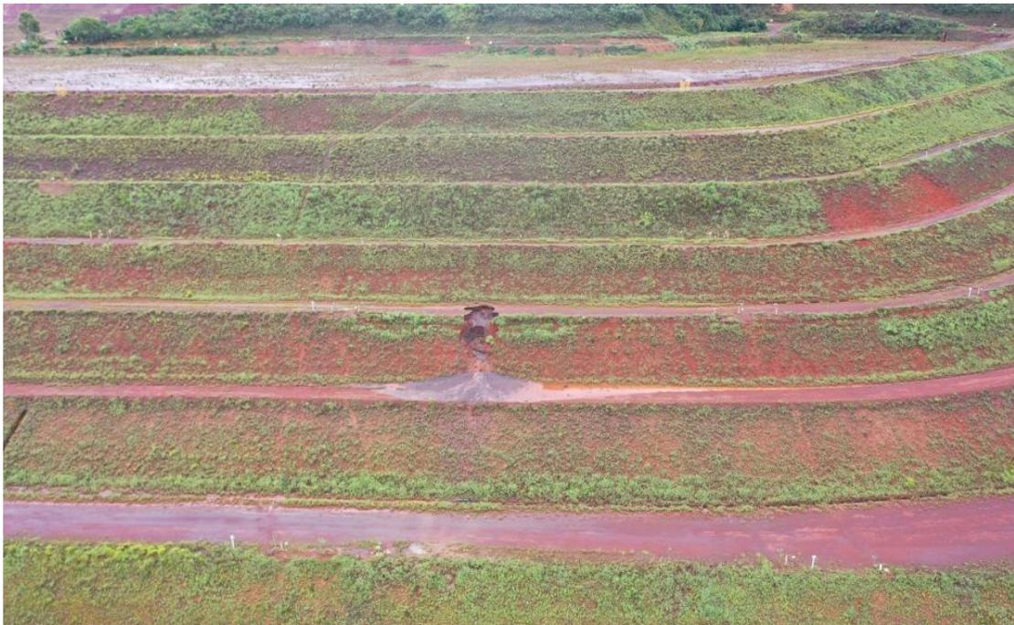
Figura 28: Erosão na cota 955, no talude de jusante, da Barragem de Rejeitos
