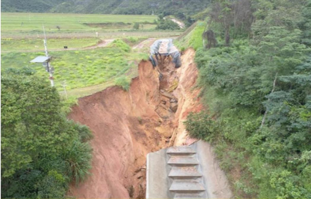
Figura 24: Destruição de trecho de canal de cintura da barragem
