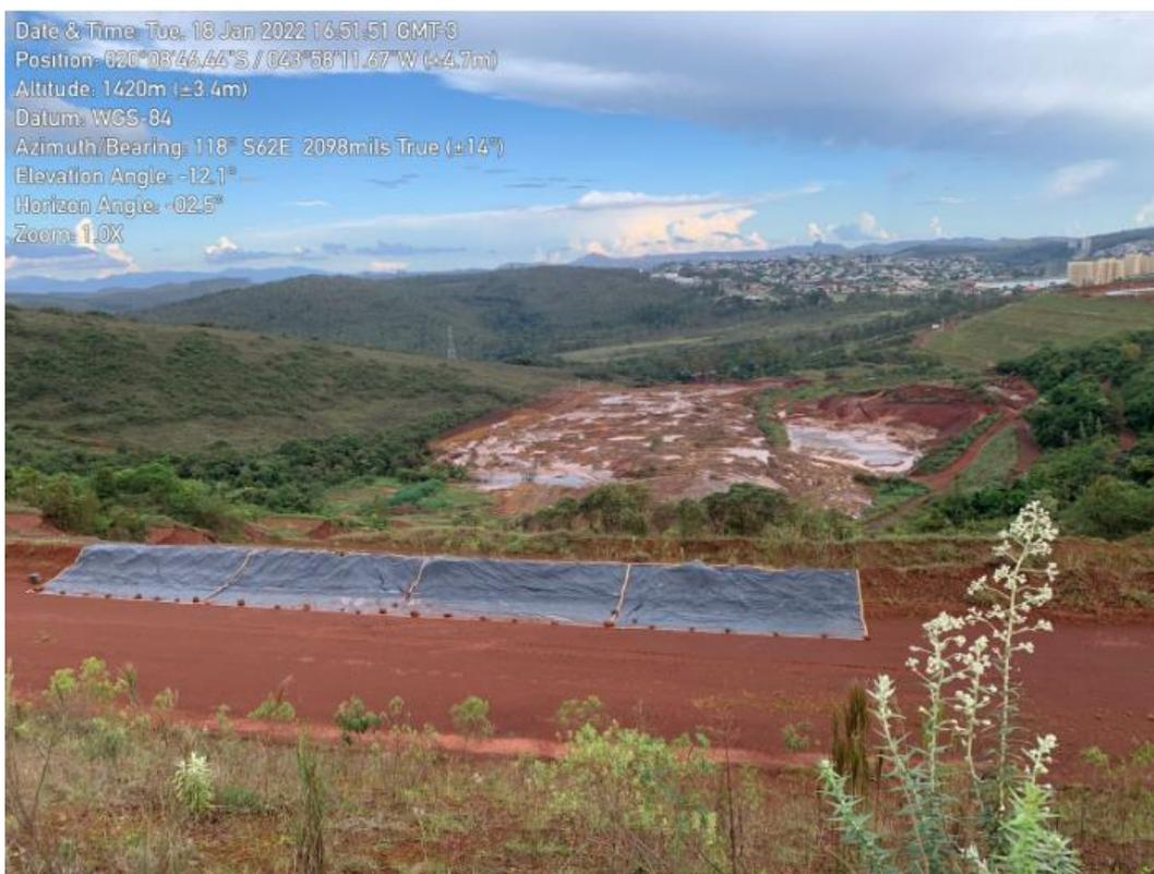
Figura 19: Reparos na região de escorregamento da Pilha Cachoeirinha, localizada a montante do reservatório do Dique Lisa.
