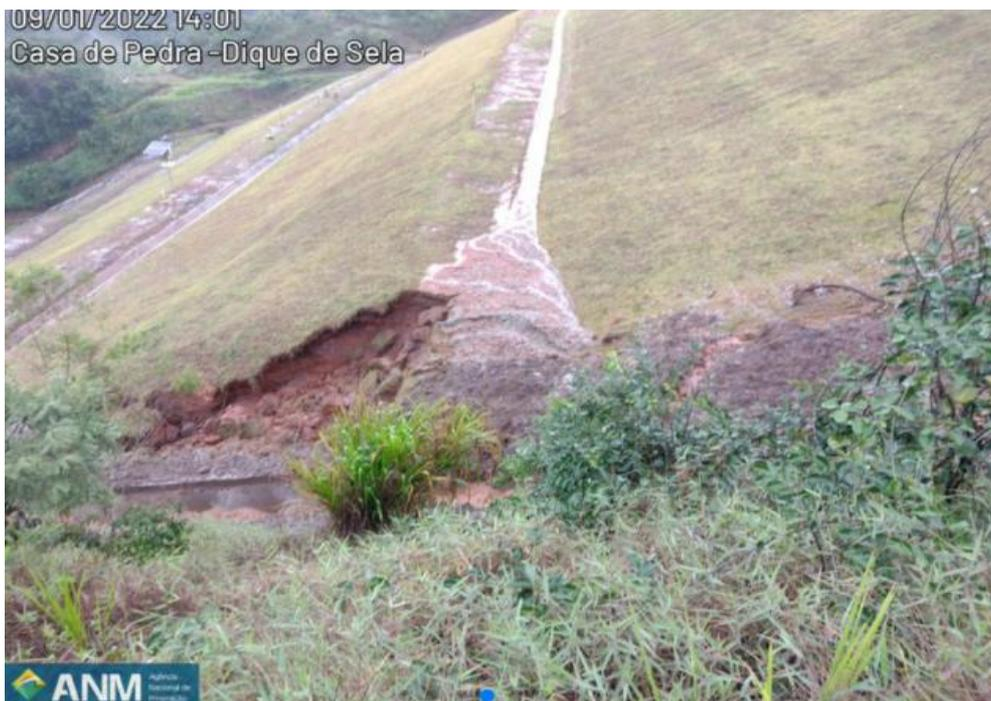
Figura 21: Erosão em dique de sela devido às chuvas intensas
