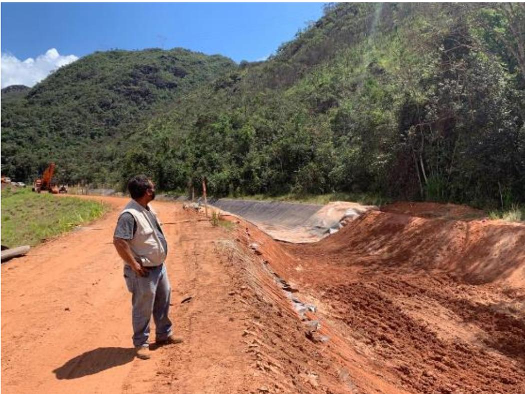
Figura 25: Obras do trecho de canal de cintura da barragem
