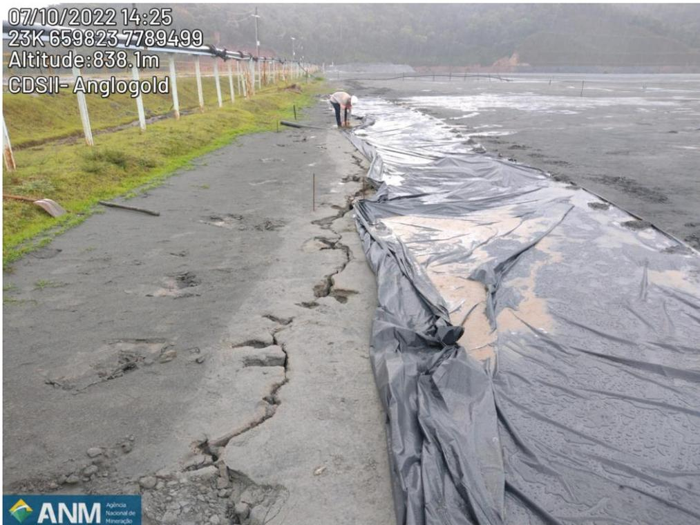
Figura 32: Trinca do reservatório
