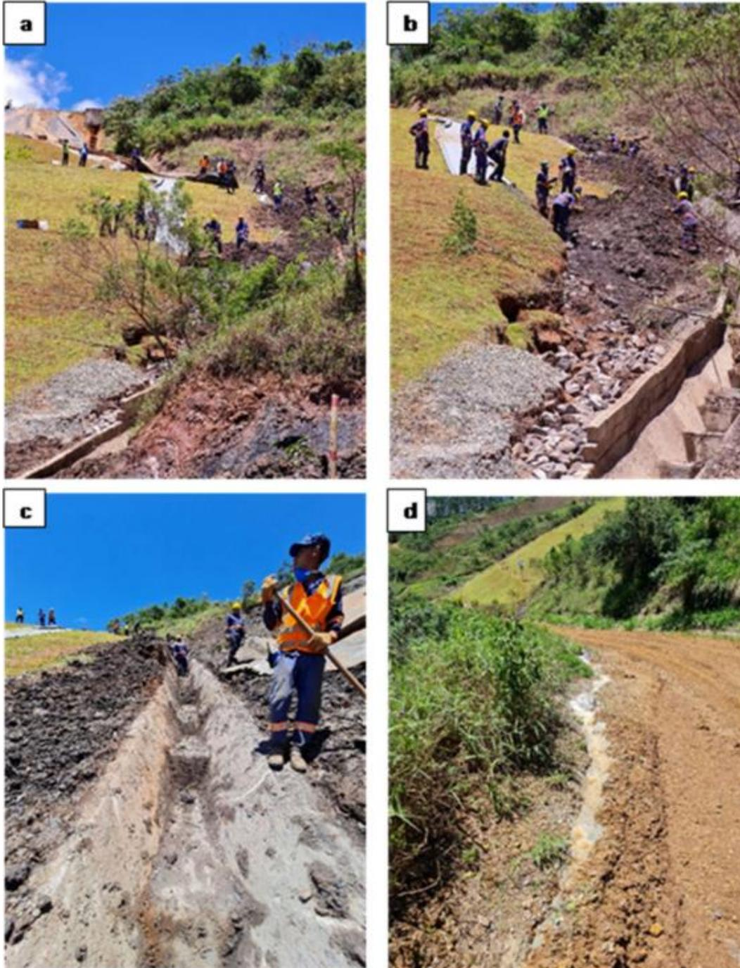
Figura 22: Medidas corretivas das anomalias identificadas na vistoria: a e b) homens trabalhando na correção das erosões no maciço do Dique de Sela; c) limpeza de canaleta que estava obstruída por escorregamentos da encosta da ombreira esquerda do Dique de Sela; e d) selamento de trinca acima de talude natural com calda de cimento
