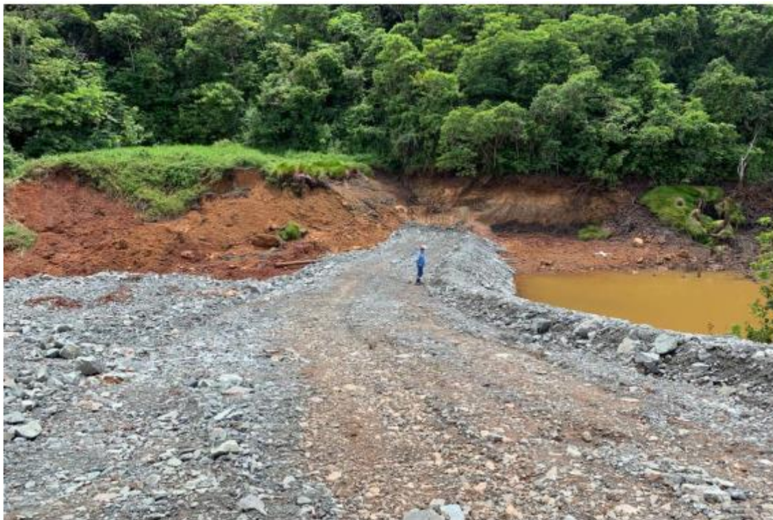
Figura 13: Reconstrução emergencial do barramento rompido.
