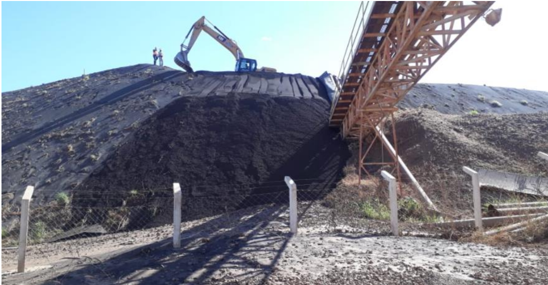
Figura 18: obras de reparo da erosão efetuadas em 13/08/2020, mesma data do incidente.
