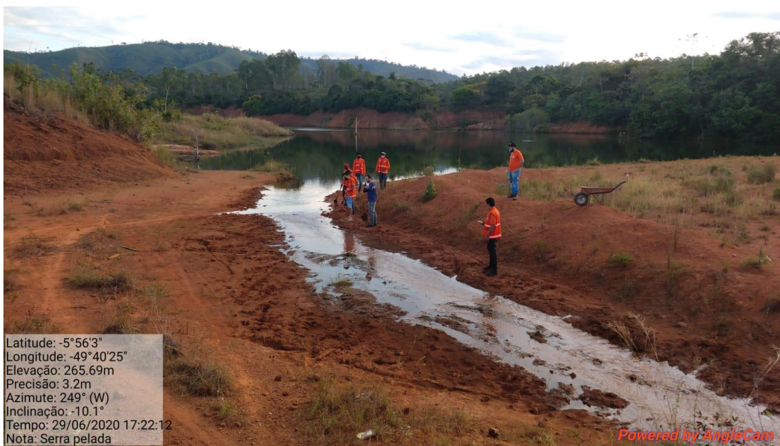
Figura 8: extravasor de emergência assoreado.
