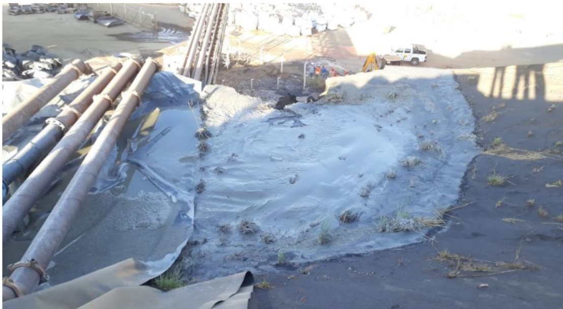
Figura 17: processo erosivo ocasionado pelo fluxo extravasado
