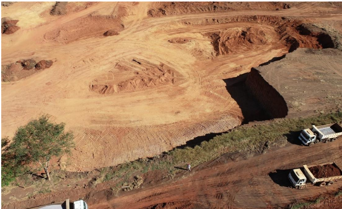
Figura 15: área de atividades de lavra a jusante da barragem Campos que foram suspensas
