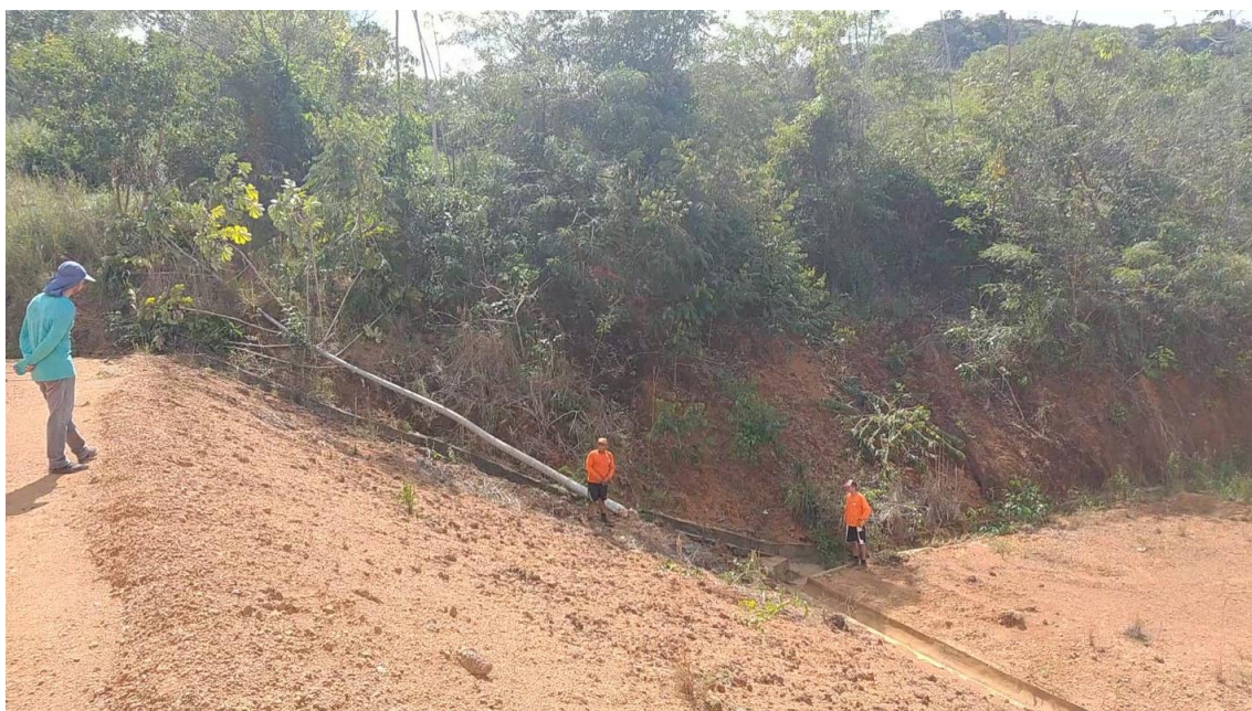
Figura 10: corte de árvores que nasceram no talude da barragem.
