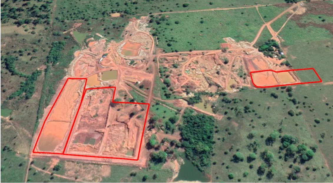
Figura 12: vista geral das barragens, destacadas da esquerda para a direita: Elvo 1, Campos e Berion.
