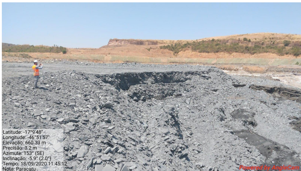
Figura 22: local do deslizamento que ocorreu no reservatório, no momento da vistoria.
