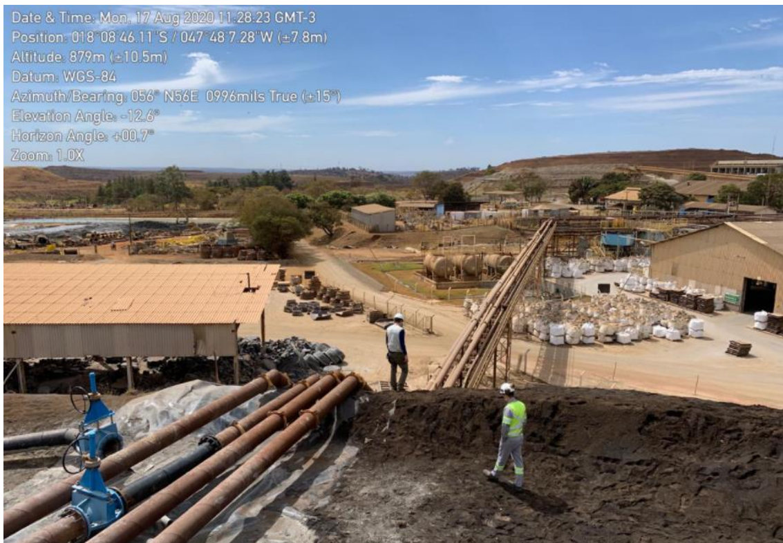
Figura 20: vista geral do conjunto de dutos reparados e área recuperada após a erosão.
