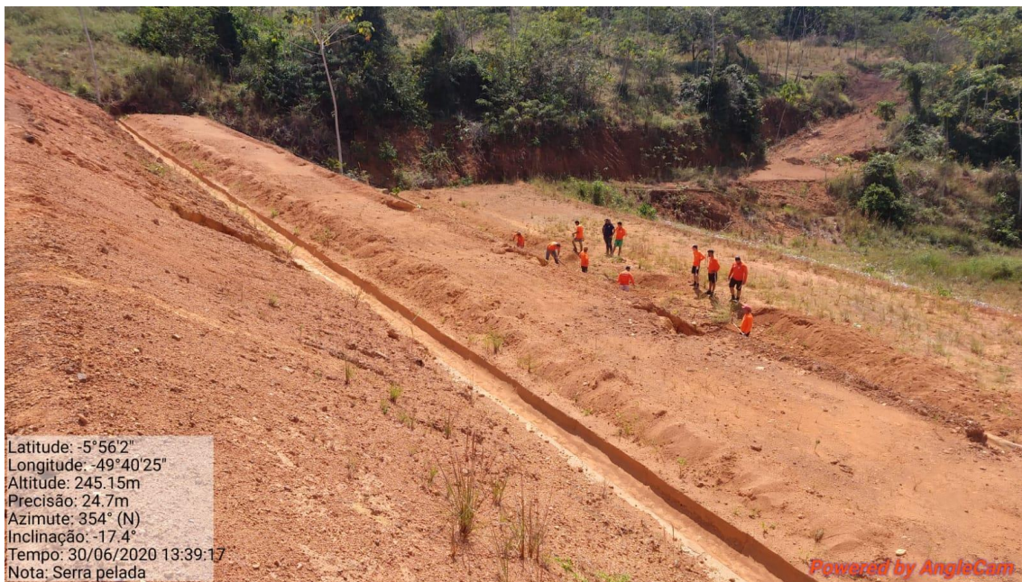
Figura 7: canaletas de drenagem superficial desobstruídas após a ação.
