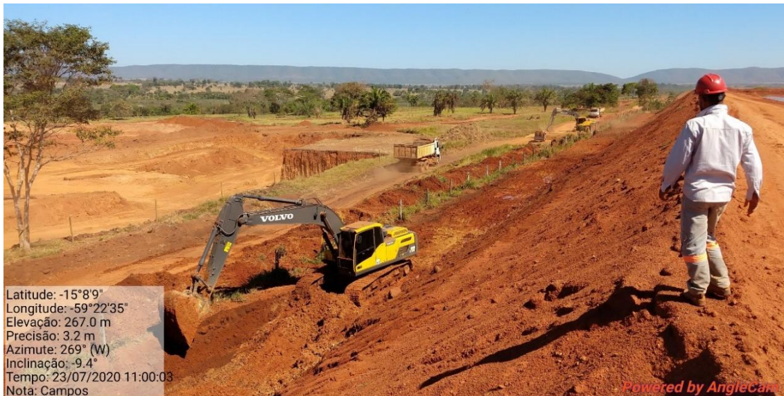
Figura 16: obras emergenciais de reforço do talude da barragem Campos após rebaixamento do reservatório.
