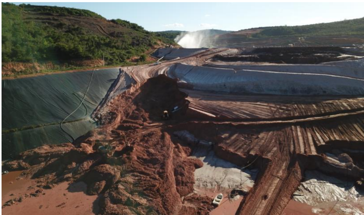
Figura 23: vista aérea da pilha após ruptura. Fonte: Jacobina Mineração e Comércio.
