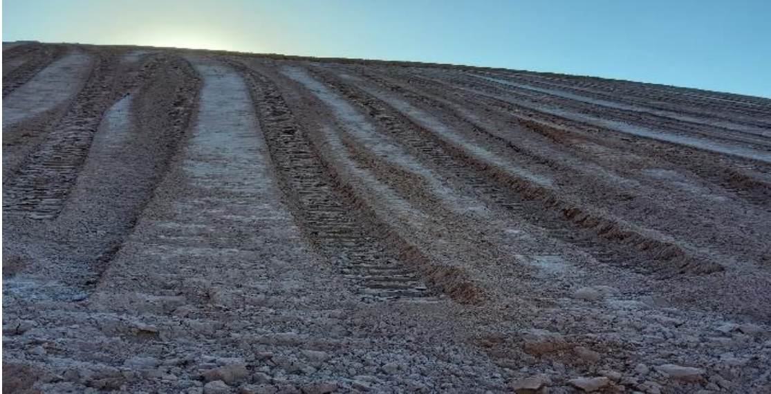
Figura 25: vista do talude da pilha após início da conformação.
