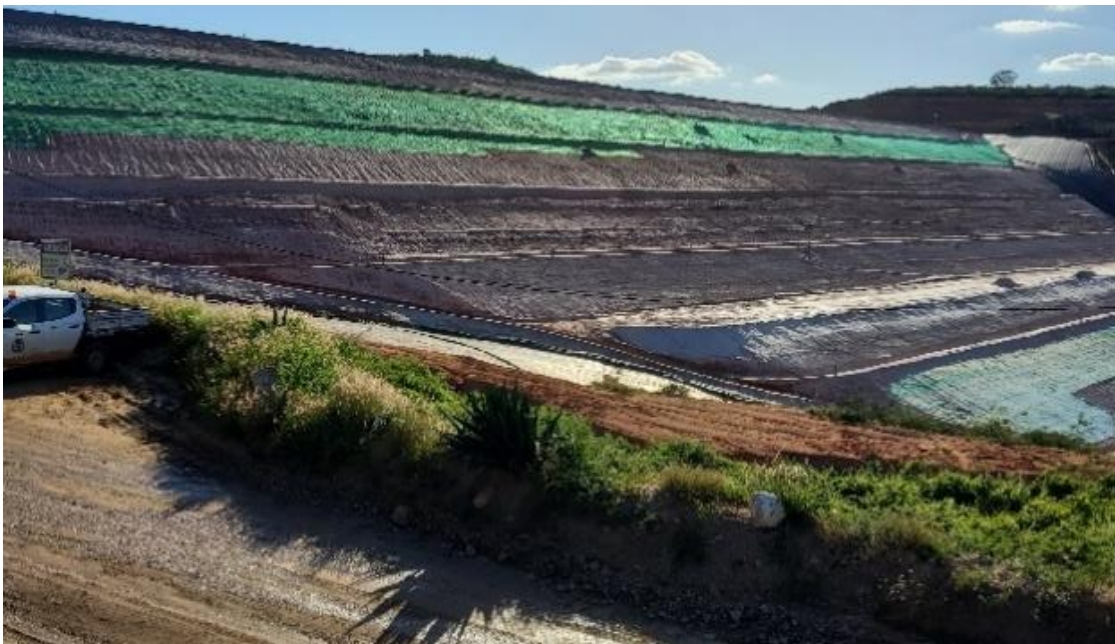
Figura 26: vista do talude de jusante da Barragem 02.
