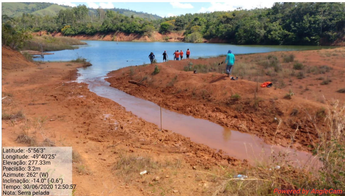
Figura 9: extrator de emergência após a limpeza pelas equipes da ANM e Defesa Civil.
