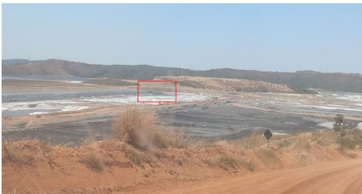
Figura 21: área de reprocessamento de rejeitos do reservatório, com indicação do local do incidente.
