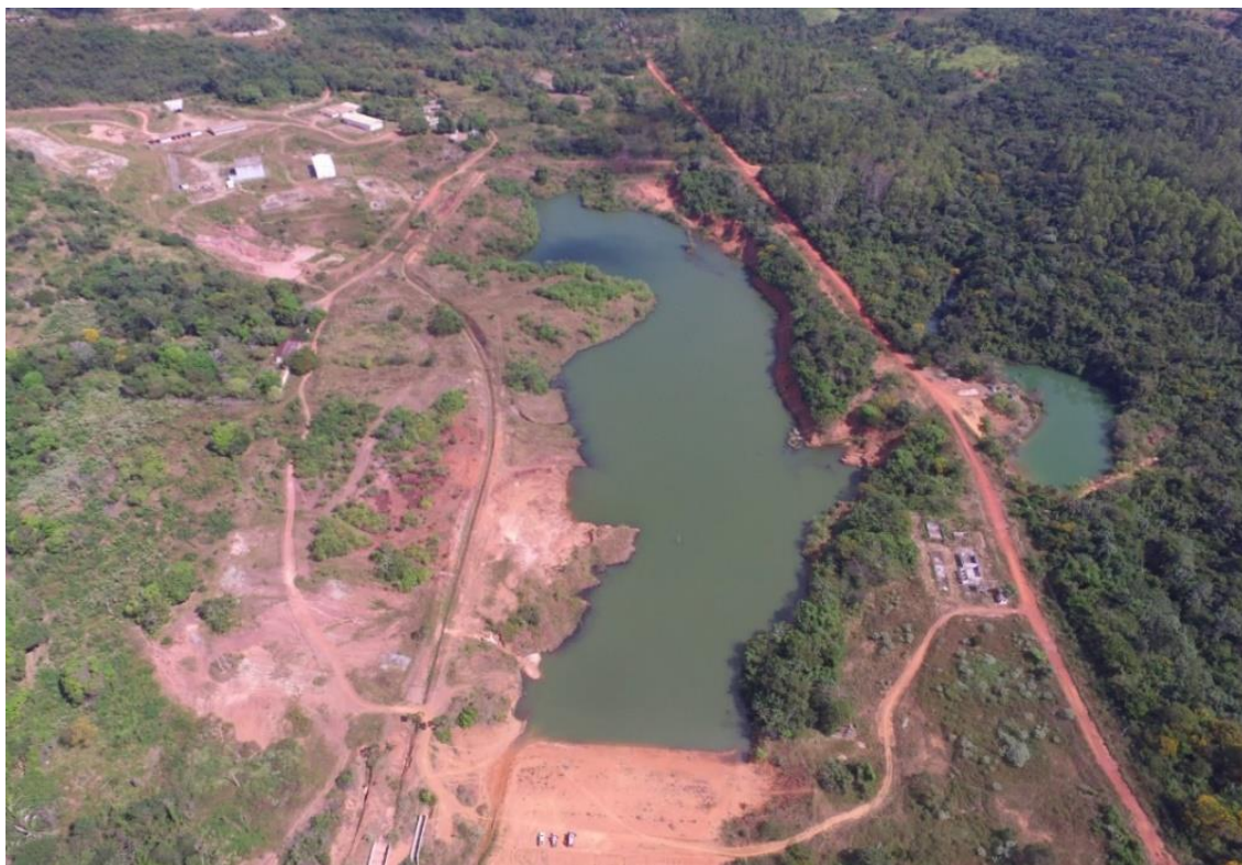
Figura 6: vista geral da barragem e reservatório
