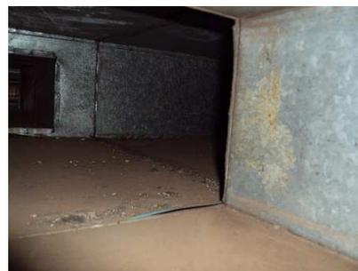
Percebe-se, portanto, a necessidade de que se proceda à execução dos serviços de limpeza robotizada, por escovação mecânica, nos dutos de ar condicionado para que se mantenha o insuflamento e a distribuição de ar saudáveis.
