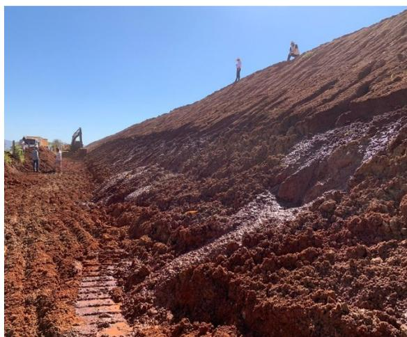
**Rompimento de tubulação na barragem Unidade I em Ouidor - GO – 17/08/2020** – Ação realizada pela equipe da ANM nas dependências da Niobrás Mineração Ltda (Grupo CMOB Brasil), município de Ouidor/GO, onde foi relatado o rompimento parcial de uma tubulação adutora de rejeitos, tendo o fluxo sob pressão erodido parte do talude de jusante da estrutura.
