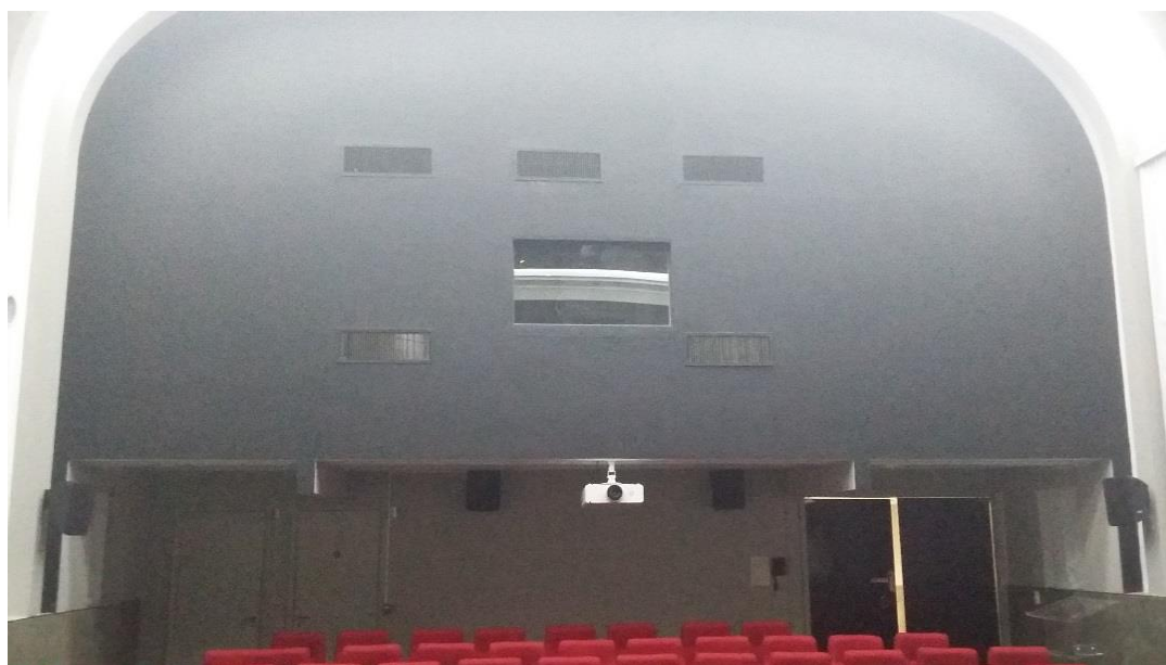
Saída (grelhas superiores) e retorno (grelhas inferiores) de ar
