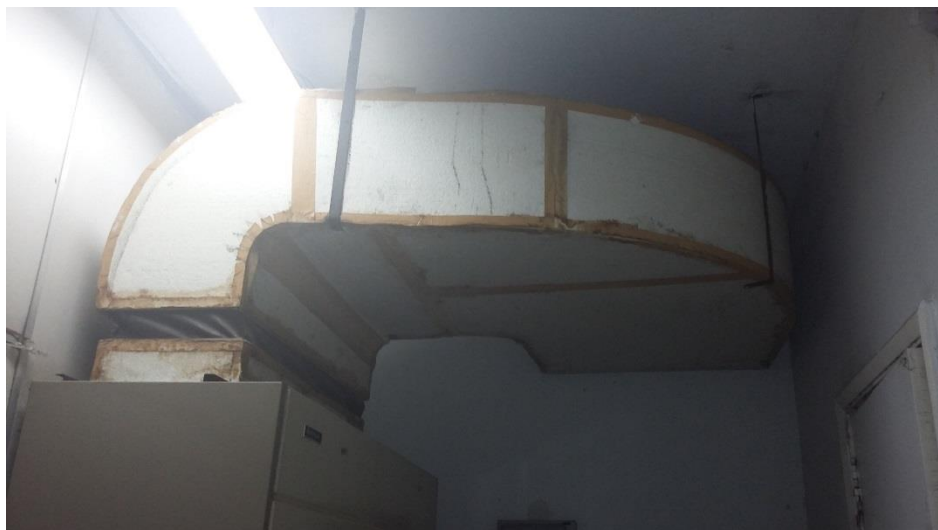
Duto de insuflamento na sala de máquinas
