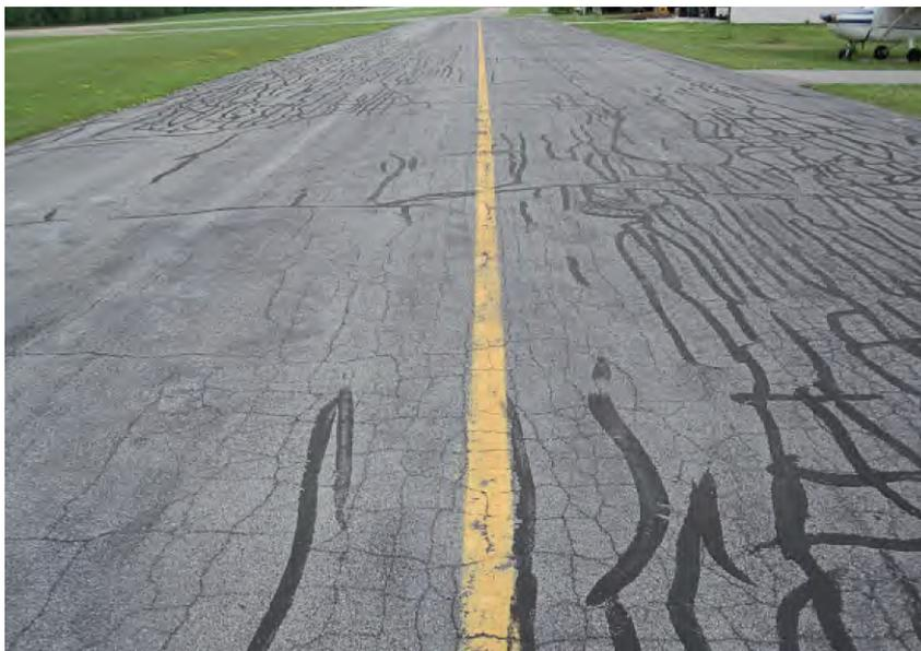
**Figura 16 – Exemplo de pavimento com PCI 20
