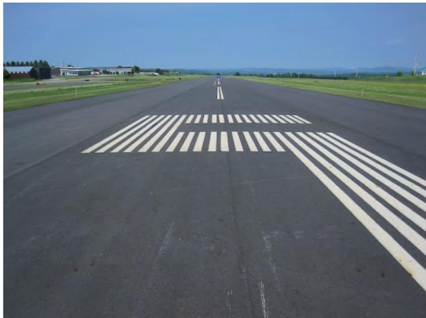
Figura 14 – Exemplo de pavimento com PCI 100
