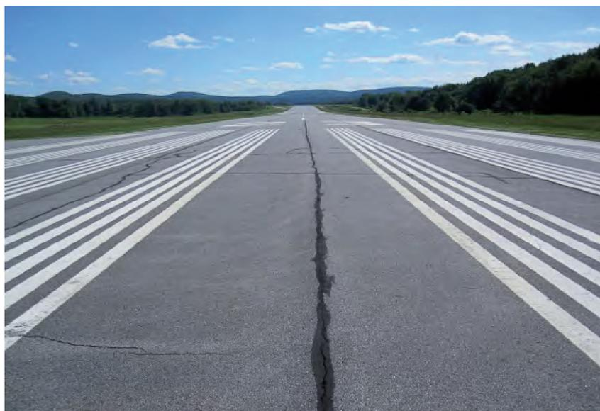
Figura 15 – Exemplo de pavimento com PCI 60
