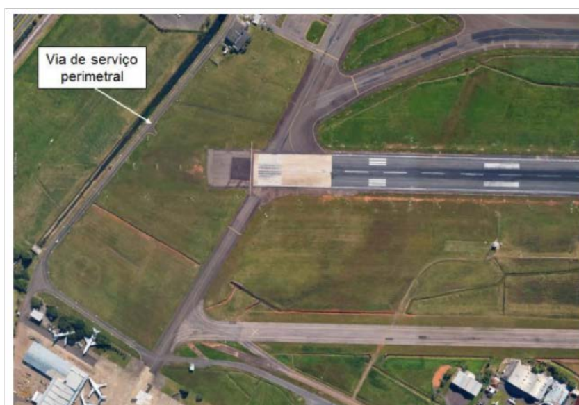
Figura D.4 – Via de serviço perimetral (construída além da cabeceira da PPD).
