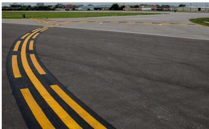
Figura 10 – Sinalizações horizontais melhorada de eixo de pista de táxi.
