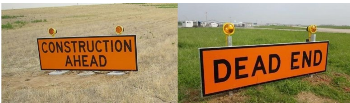
Figura 42 – Exemplos de sinalizações verticais temporárias de obra (Fontes: CDG e ORY)
