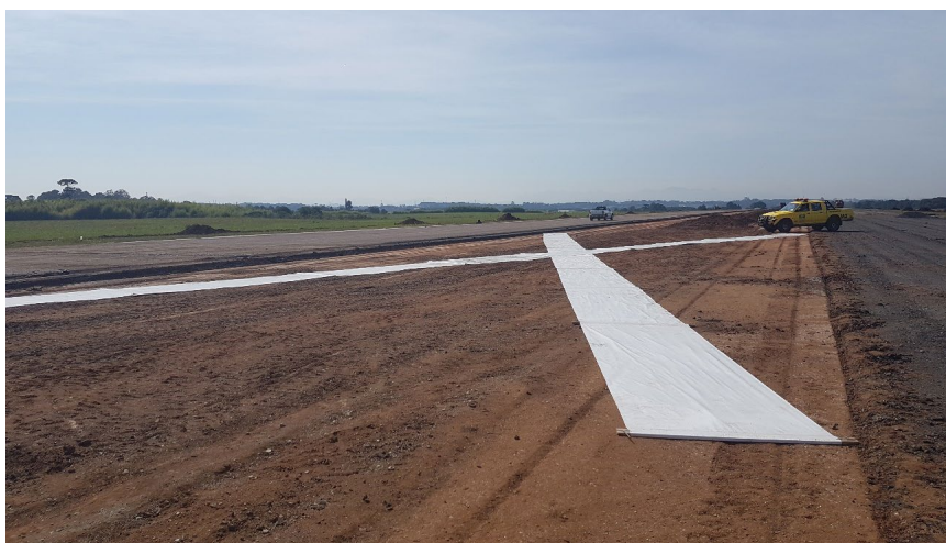
Figura 23 – Sinalização de interdição de pista de pouso e decolagem em material plástico
