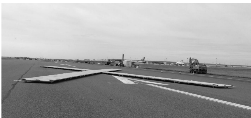
Figura 24 – Sinalização de interdição de pista de pouso e decolagem em madeira (Fonte: Aéroport de Paris – CDG)
