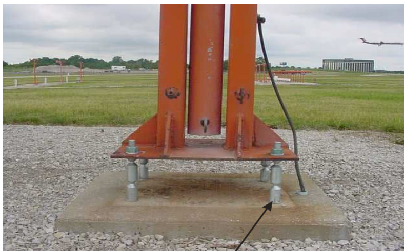
Figura 1 – Aplicação de parafuso "fusível" (Fonte: DOC 9157 – Part 6)
