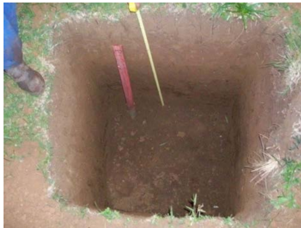
Figura 10. Abertura de janela em área não pavimentada.
