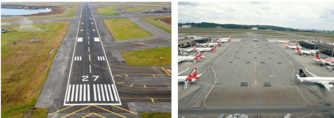
Figura 7. Imagens aéreas para avaliação geométrica das infraestruturas.
