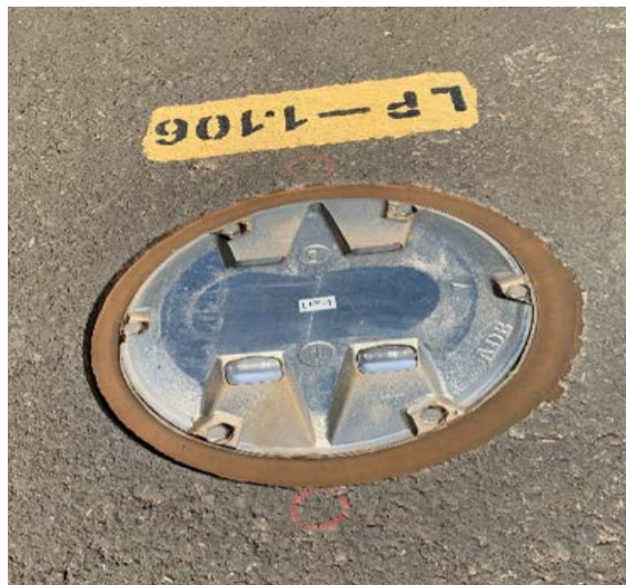
Figura 36. Nivelamento da luz embutida em relação à superfície.
