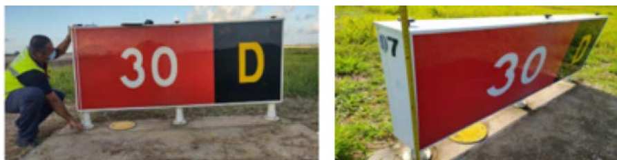
Figura 40. Medidas realizadas in loco da altura das placas de sinalização vertical.
