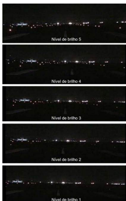
Figura 34. Trechos de vídeo que mostra o controle da intensidade das luzes de borda de pista de pouso e decolagem.
