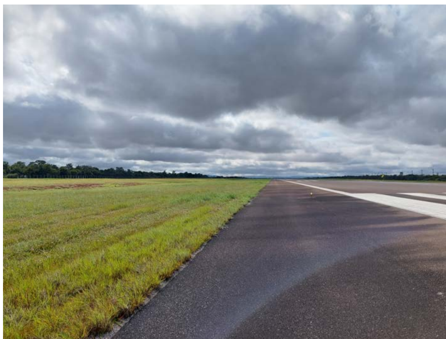
Figura 24. Nivelamento entre as superfícies do acostamento da pista e da faixa preparada.
