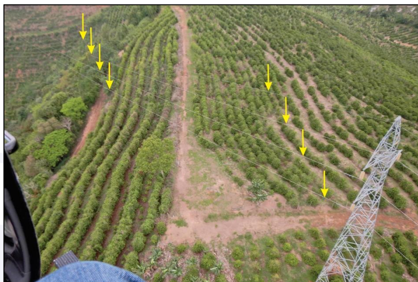
Figura 21 - Demonstração do contraste dos cabos e da torre, em relação ao terreno. As setas indicam as posições dos cabos entre duas torres.
