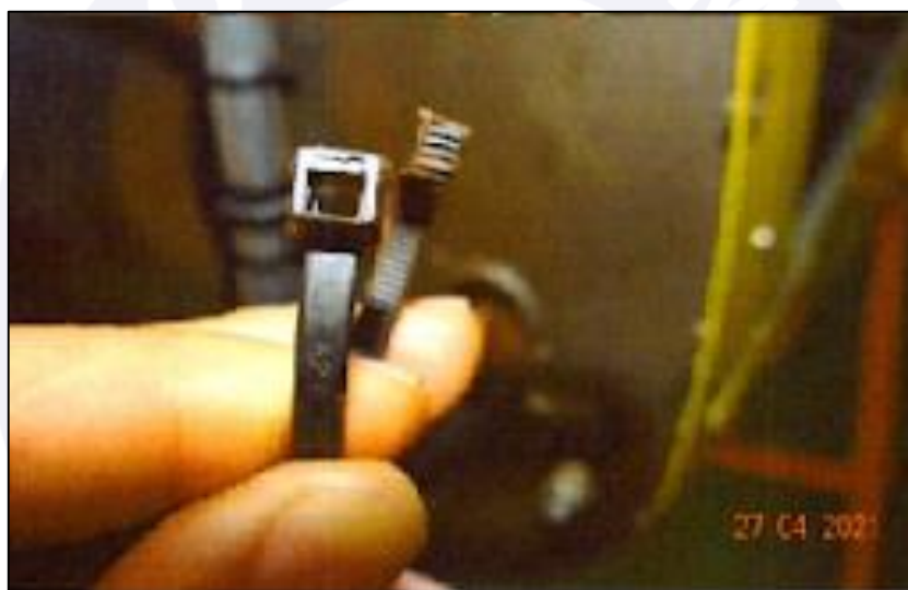
Figura 3 - Braçadeira de plástico encontrada no berço do motor com a trava quebrada.
