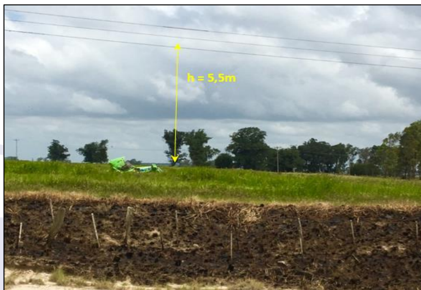
Figura 3 - Altura da rede elétrica em relação ao solo.
