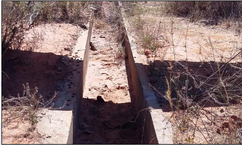
Figura 3 - Vala de escoamento de águas pluviais.
