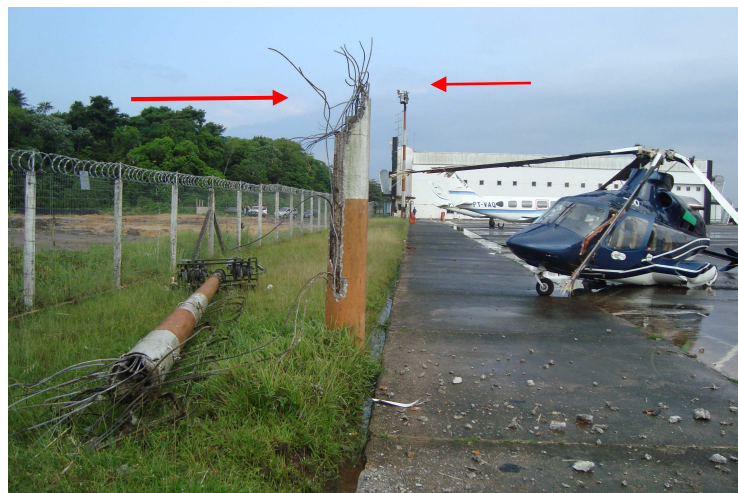
Figura 5 - Torres de iluminação na extremidade do pátio.
