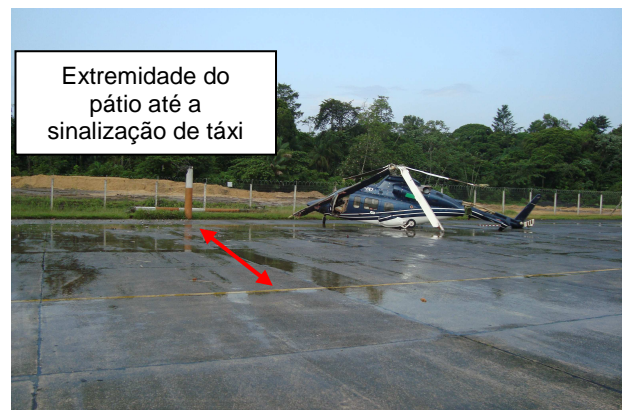
Figuras 3 e 4 - Distância entre a sinalização horizontal existente no solo e a extremidade do pátio.
