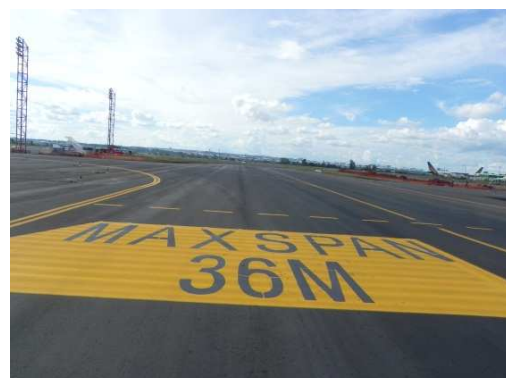
Figuras 6 e 7 – Marcação padrão adotada pela ACI e a marcação na pista de táxi R antes do ingresso na pista de táxi L4.
