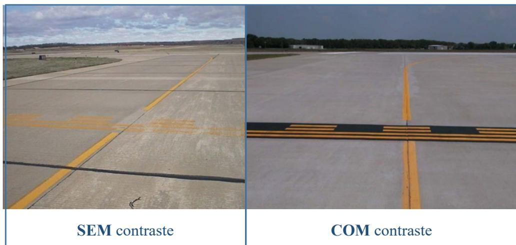
Para manter o grau de contraste (conspicuidade) entre a sinalização horizontal e o pavimento de modo a possibilitar sua integral visualização pelo piloto e demais usuários da área operacional, o operador de aeródromo deve atender ao disposto no “RBAC nº 154 – Projeto de Aeródromos”, especialmente em seus parágrafos 154.301(a)(3)(iv), 154.303(a)(2), 154.303(g), 154.303(l), 154.303(p)(3)(iii) e 154.303(q)(3)(ii). O RBAC nº 154 está disponível no seguinte endereço eletrônico:
