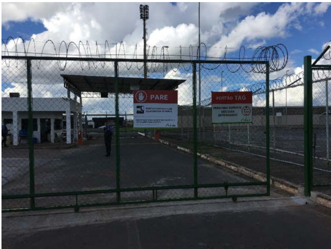
Figura 13 – Portão de acesso de veículos com avisos de alerta
