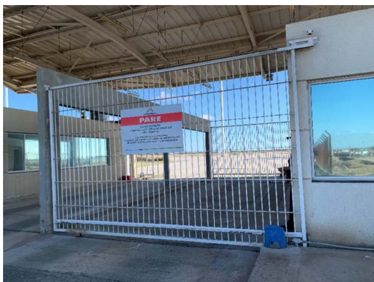
Figura 12 – Portão de acesso de veículos em grade
