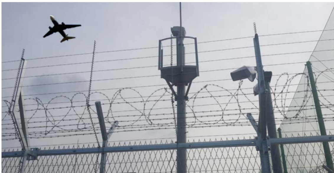
Figura 3 – Aeroporto na Coreia onde se utiliza sistema de vigilância por câmeras de alta precisão conjugadas com alambrados com concertina e cerca eletrificada
