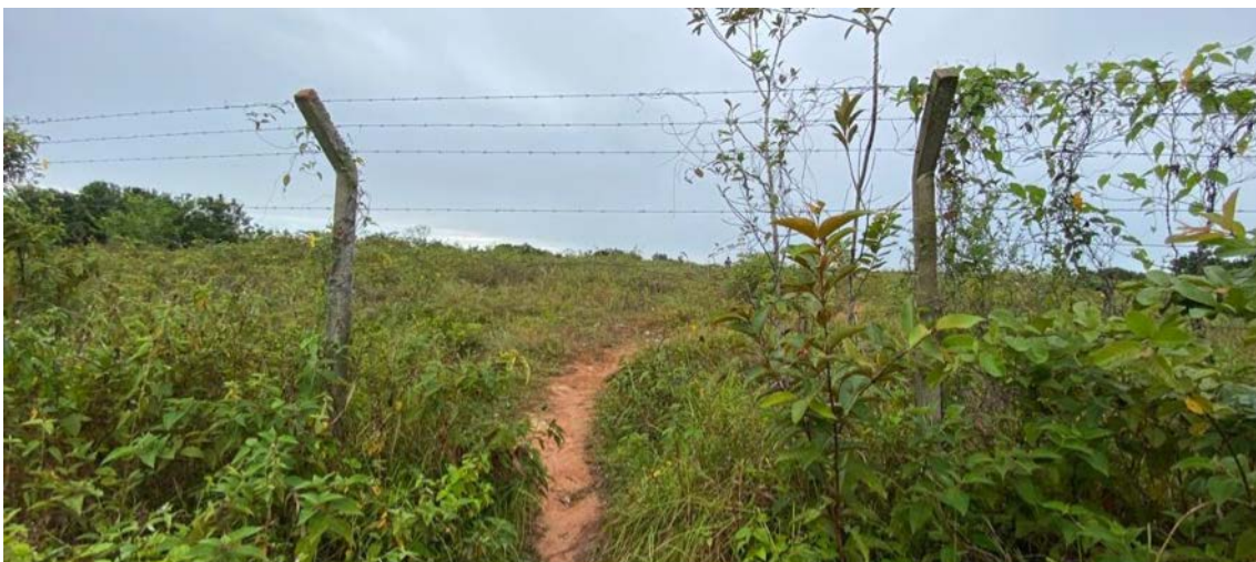
Figura 18 – Barreira de segurança com defeito – Rasgos na cerca de arame farpado permitem passagem de pessoas e animais, sendo visível, inclusive, um caminho que indica que este fluxo tem ocorrido
