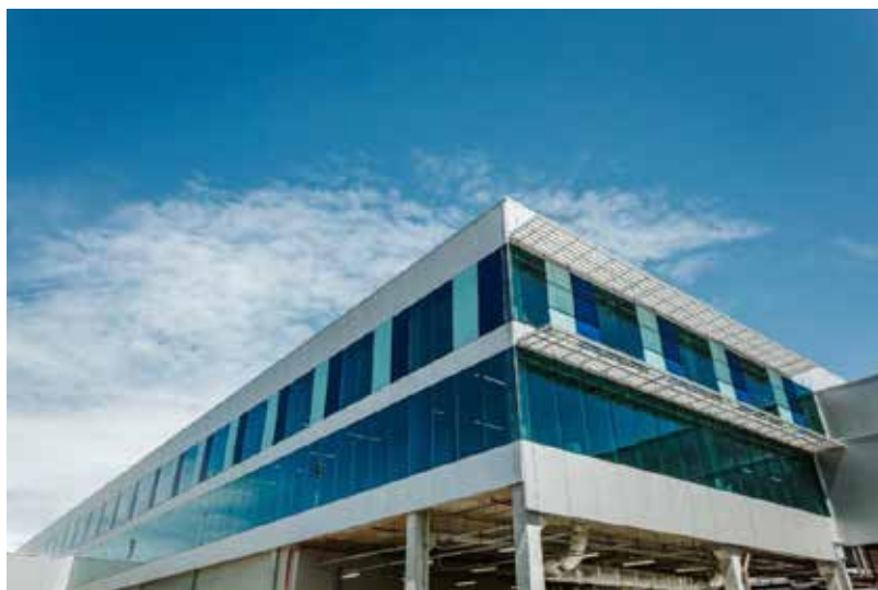
Figura 3. Aplicação de vidros insulados no Aeroporto Internacional de Salvador - Cortesia: VINCI Airports
