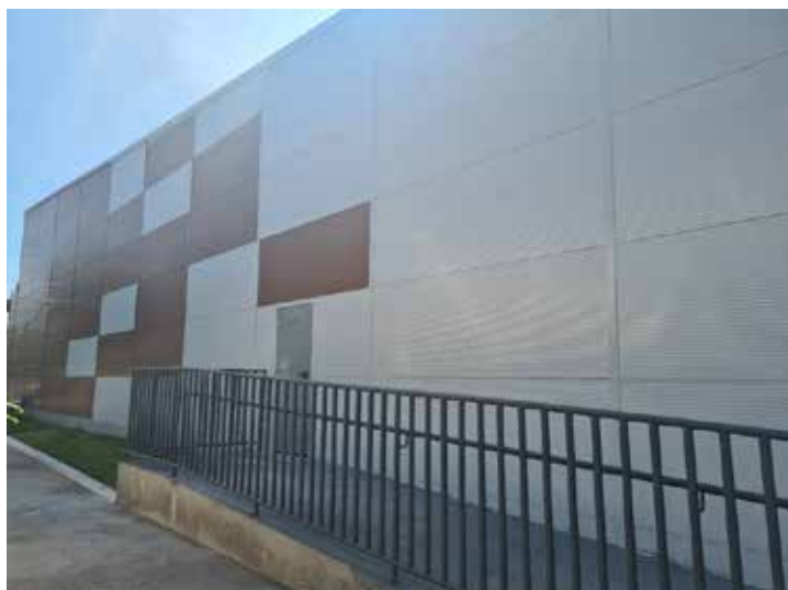
Figura 2. Isolamento termoacústico do terminal do Aeroporto de Montes Claros - Cortesia: Infraero
