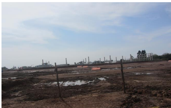
Figura 2-23 – Obra paralisada do novo TECA
