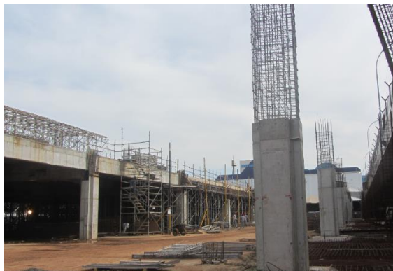
Figura 2-15 – Obras de ampliação do TPS-01 em andamento
