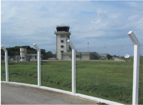
Figura 2-7 – Torre de Controle
