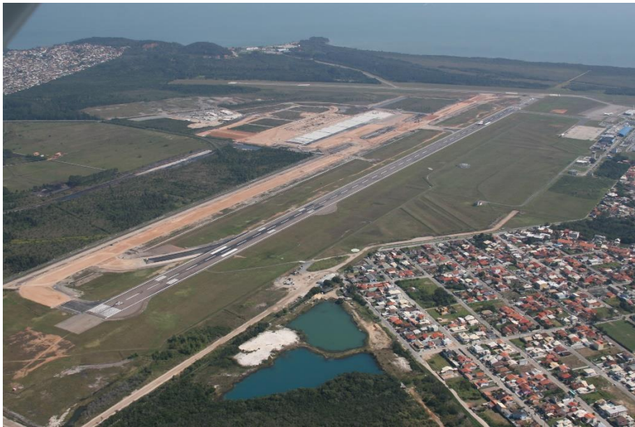
Figura 2-31 – Imagem aérea das obras iniciadas
