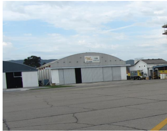
Figura 2-26 – Hangar de Aviação Geral
