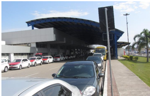
Figura 2-21 – Via de acesso ao meio-fio de embarque e desembarque
