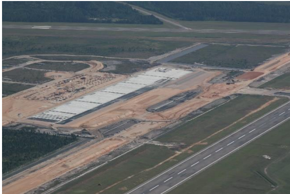
Figura 2-33 – Imagem da área em obras do TPS e Pátio de Aeronaves
