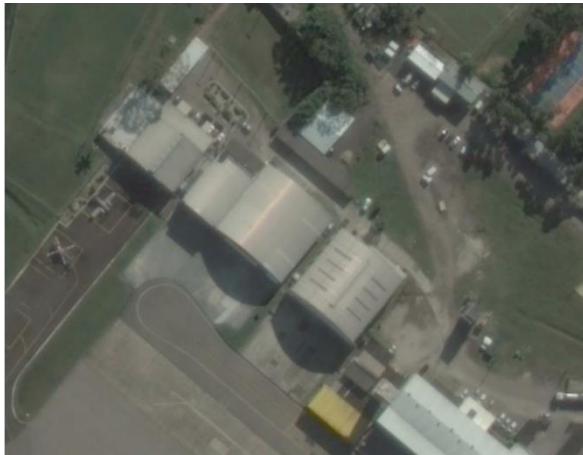
Figura 2-25 – Imagem aérea dos Hangares de Aviação Geral
