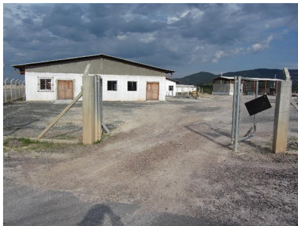
Figura 2-32 – Canteiro de Obras
