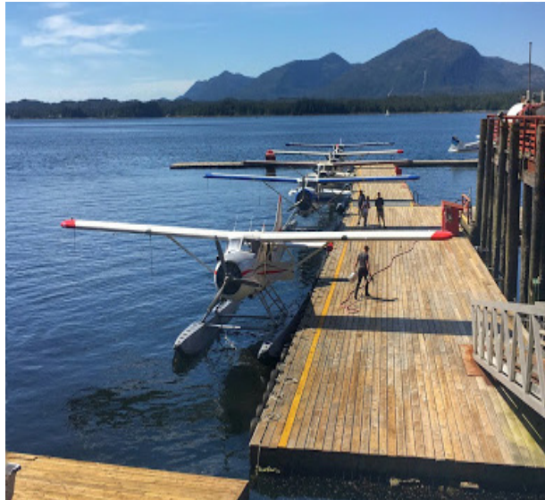
Figura 28 Cais com linha amarela sinalizando área de risco
