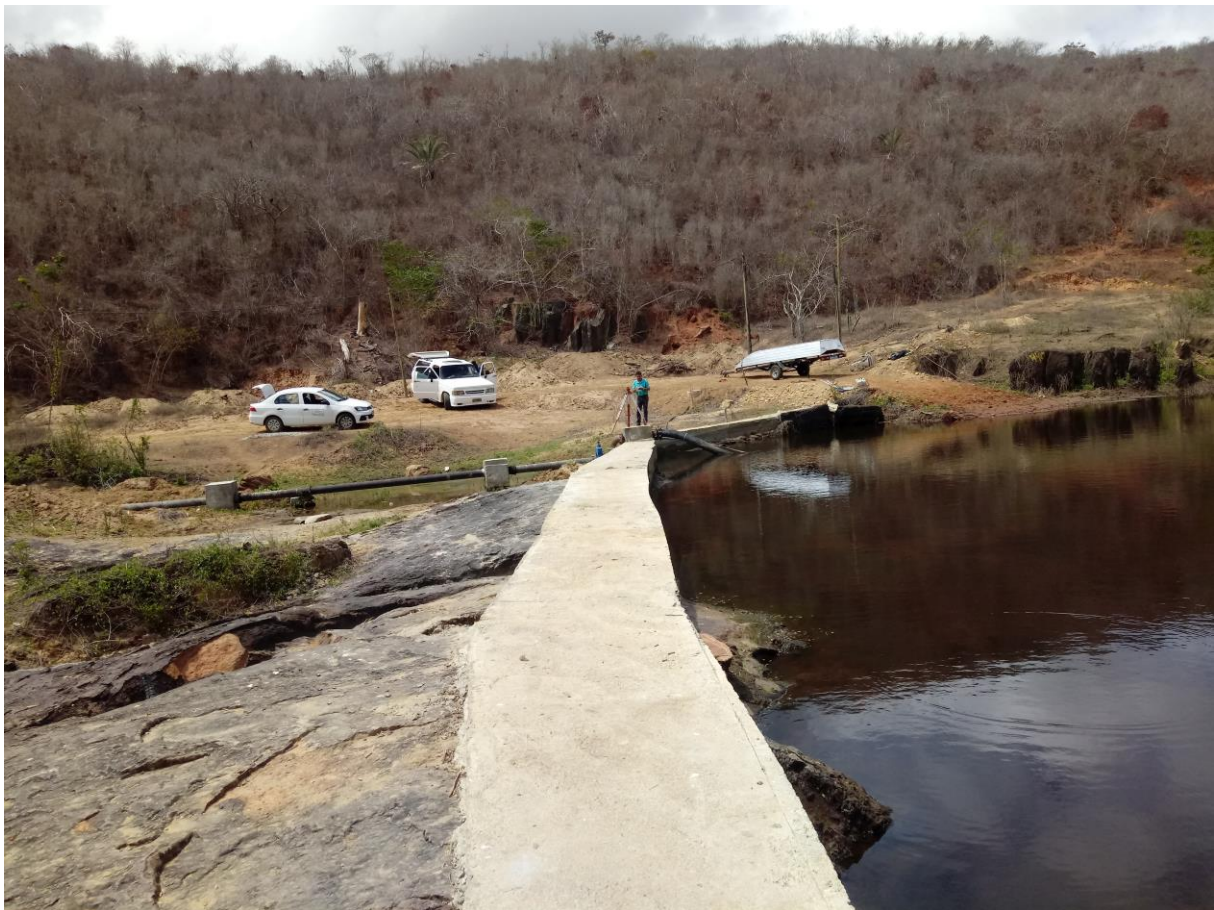
Foto 1 – Barragem de Nível do Rio Pardo
