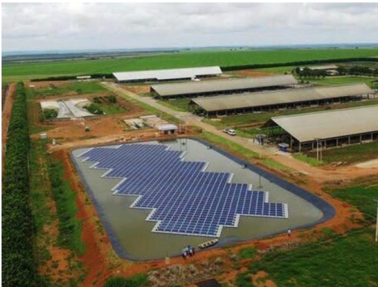
Figura 3.9 - Planta solar flutuante – Fazenda Figueiredo, em Cristalina – GO
