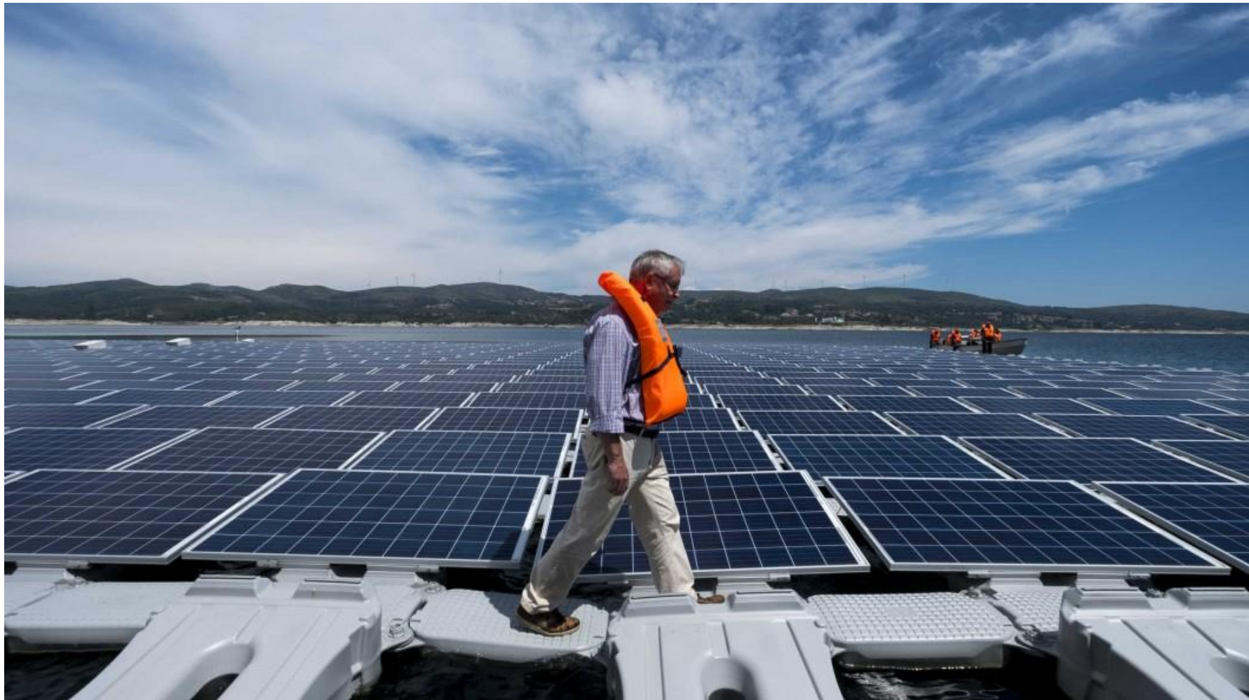
Painéis fotovoltaicos da EDP na Barragem do Alto Rabagão - Portugal
