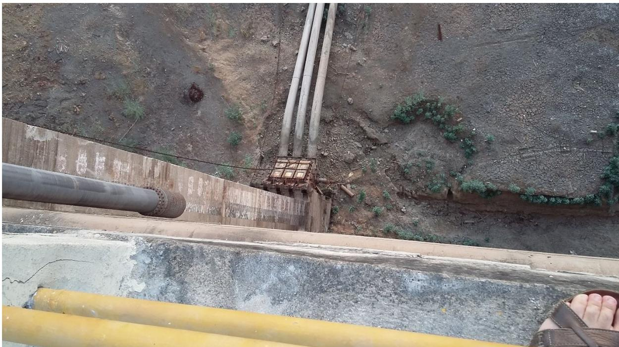
**Figura 3 – Dupla adução para descarga a jusante – sifão e flutuante (montante)**
