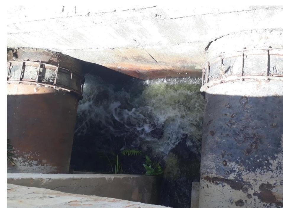
Vazamento na tubulação dentro da galeria
