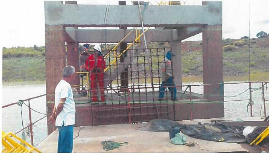
Figura 03 – outra visão da grade, guarda corpo e recuperação do revestimento.
