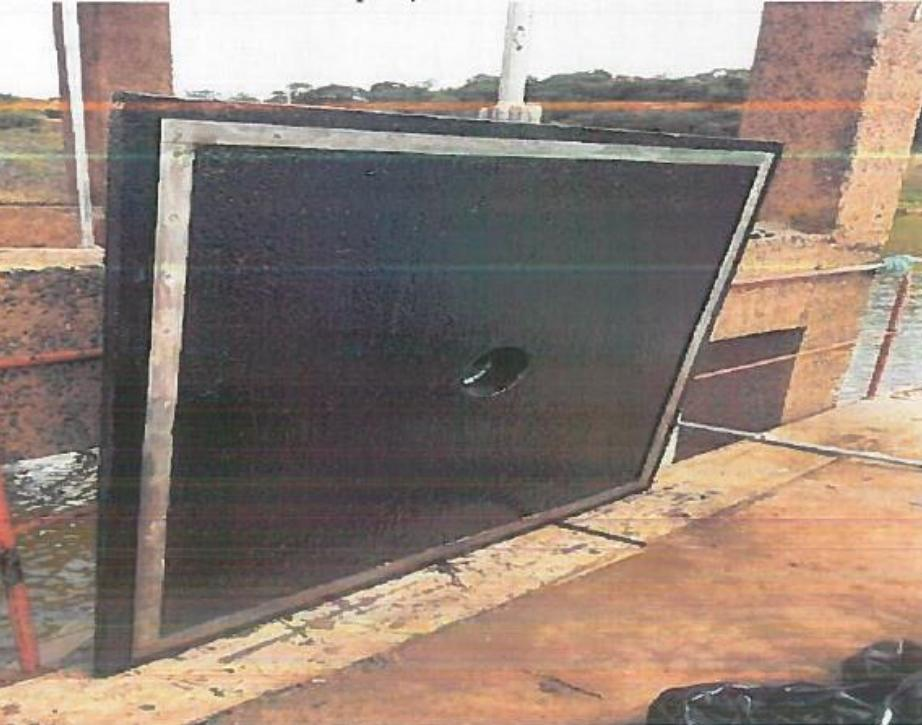
Figura 02 – Vista da comporta desmontada, içada, jateada e pintada.
