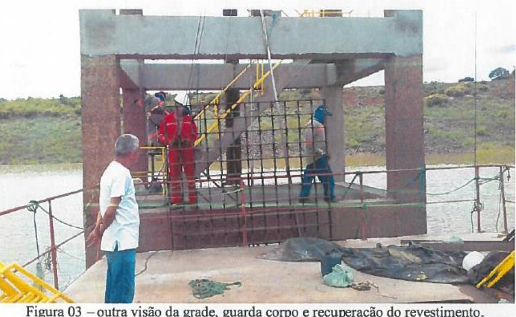
Figura 03 – outra visão da grade, guarda corpo e recuperação do revestimento.
