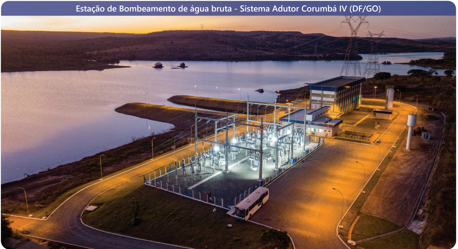
Captação de água bruta - Sistema Adutor Corumbá IV (DF/GO)
