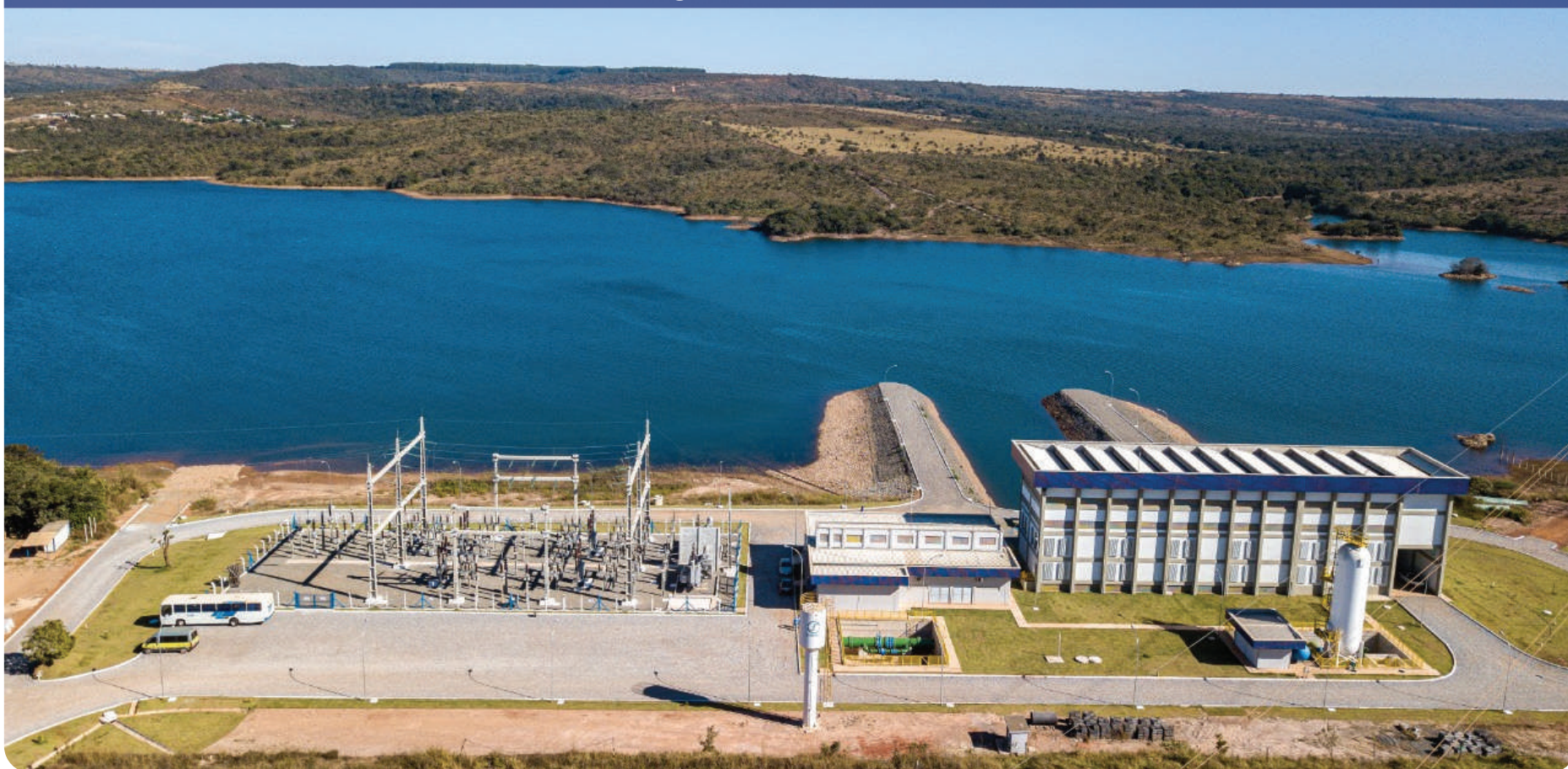
Estação de Bombeamento de água bruta - Sistema Adutor Corumbá IV (DF/GO)
